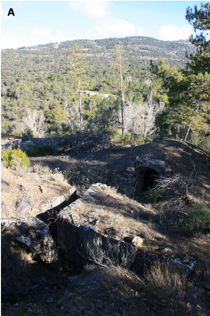
Figura 52. Refugio subterráneo de Valsequillo (VSQ-003: RCH/n). A) Rectangular (3x1,50 m), mampostería con mortero de cemento y acceso desde trinchera en relieve. B) Interior con bóveda rebajada y blindada (encofrado de hormigón).
