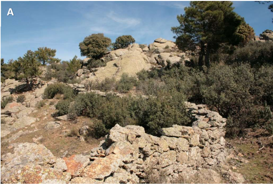
Figura 197. Parapetos simples del bando nacional. A) Ciudad Prohibida (CPH_092: SMA/n): Parapeto de mampostería a hueso de 70 m de longitud y dirección N-S. Presenta una anchura de unos 0,70 m y una altura de 1,20 m. Enlaza con el PT CPH-049 por el N y con los PT's CPH-048 y 082 por el S. Presenta un trazado muy extenso, a lo largo de todo el CoDe. B) Pilón (PIL-033: SMA/n): Parapeto de mampostería a hueso de 6,50 m de longitud y dirección NO-SE. Presenta unas dimensiones de 1,20-1,40 m de altura y 0,80 de espesor. Parece corresponder a un trazado previo del perímetro defensivo, junto con el PIL-035. C) Santa Catalina (SCT-005: VMQ/n): Obra de mampostería a hueso de 28 m de longitud y dirección NO-SE.
