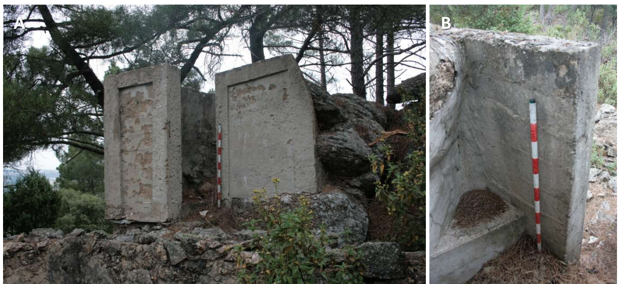
Figura 40. Observatorio de la Ciudad Prohibida-N (CPN-020: SMA/n). A) Construcción cuadrangular de hormigón, de 2,75x2,55 m, que aprovecha los afloramientos de bolos de gneis existentes. Los lienzos del exterior están decorados con un pequeño friso. B) Presenta escalón para la observación.
