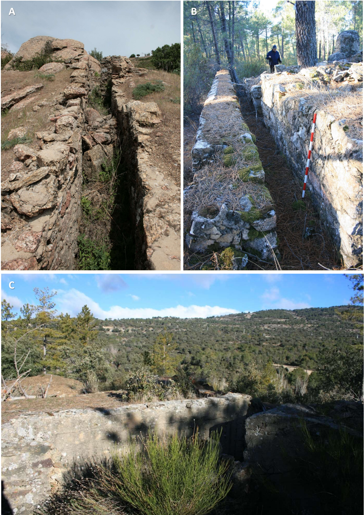
Figura 194. Otros ejemplos de trincheras nacionales en relieve. A) Peña Mocha Baja (PMB-011: SMA/n): 25 m de trinchera elevada de mampostería con mortero de cemento y una altura media de 1,50 m. Su dirección es N-SO B) Perusa (PER-008: VMQ/n): Trinchera en relieve de mampostería con mortero de cemento. Sigue una dirección NE-SO y presenta una altura media de 1-1,20 m y una longitud de 30 m. C) Valsequillo (VSQ_021: RCH/n): Trinchera de mampostería de gneis con mortero de cemento y una altura media de 1,50 m. Se orienta según NE-SO, durante 50 m de longitud.
