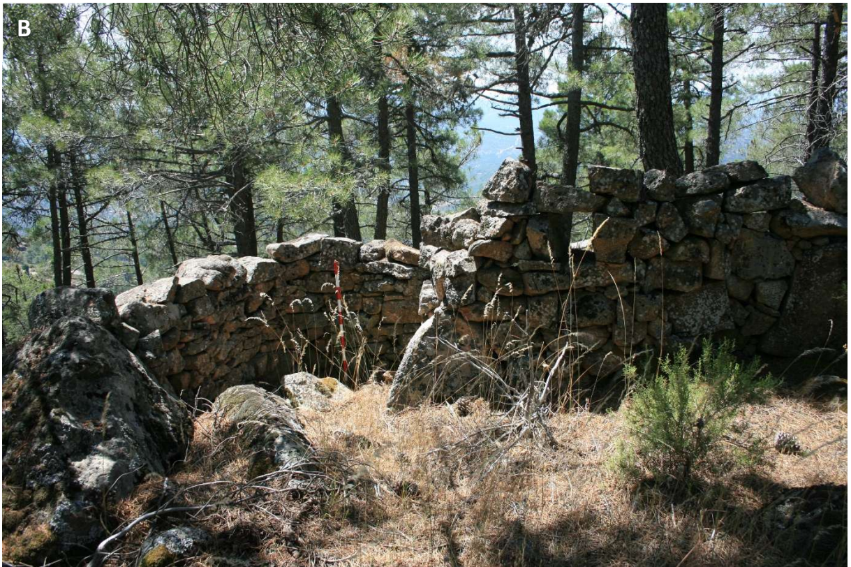
Figura 199. Parapetos aspillerados del bando nacional. A) El Turrál (TRR-001: VMQ/n): Parapeto aspillerado de mampostería a hueso, con un espesor de 0,30-0,50 m y una altura media de 1,20 m y ubicado sobre el lanchar granítico. Presenta una longitud de 40 m y dirección N-S y aparece dividido en tres tramos, con sus correspondientes puertas y accesos al conjunto defensivo. B) El Turrál (TRR_017: VMQ/n): Parapeto aspillerado de mampostería a hueso. Se observan aspilleras en su trazado, una muy cerca del fortín TRR-006. Tiene un trazado de 19 m y dirección E-O.
