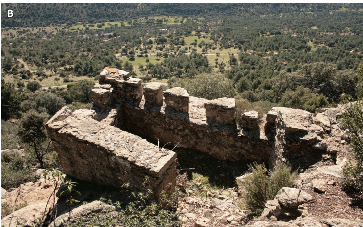
Figura 167. Fortines 5º Regimiento rectangulares. A) Las Mesetas-Navalespino NVS-016: SMA/r): Elemento de mampostería de sillarejos de gneis con cemento, de 4,70x2,90 m. Vestigios de techo blindado y puerta de acceso desde el SE, en el mismo muro donde se abren 3 aspilleras. Se encuentra a unos 10 m al SE del fortín circular NVS-017 (ver Fig. 162), con el que “casi” formaría uno de los tipos que hemos denominado de morfología mixta (N.A.).- Presenta huellas de vandalización por grafitis. B) Robledillo-S (RBS-007: RCH/r): Obra rectangular, de 4,75x3 m, realizada en mampostería (sillarejos de gneis) con mortero de cemento. Presenta 4 aspilleras (orientadas al S) y 2 troneras (una, también, orientada al S y la otra al E) que le dan un aspecto almenado. No se conserva techo, aunque en su entorno se aprecian restos de hormigón; por lo que, si existió, debió ser plano.
