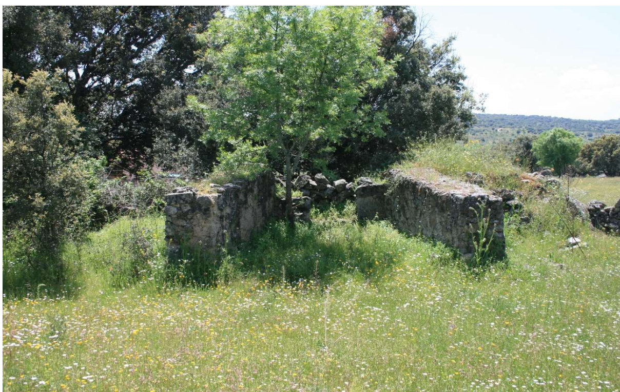
Figura 180. Asentamiento artillero de Matarubias (MTR-003: RCH/r). Está constituido por dos lienzos de muro, de 3,40 m cada uno, de mampostería de granitoide sellado con mortero de cemento que se encastra en un parapeto de unos 100 m, construido en piedra seca y de una altura aproximada de 1,30 m. La forma que presenta el emplazamiento semeja a la letra griega Pi y no queda constancia de ningún tipo de cubierta. Su adscripción como asentamiento artillero queda recogido en los manuales artilleros y es común a obras semejantes en la Comunidad de Madrid.
