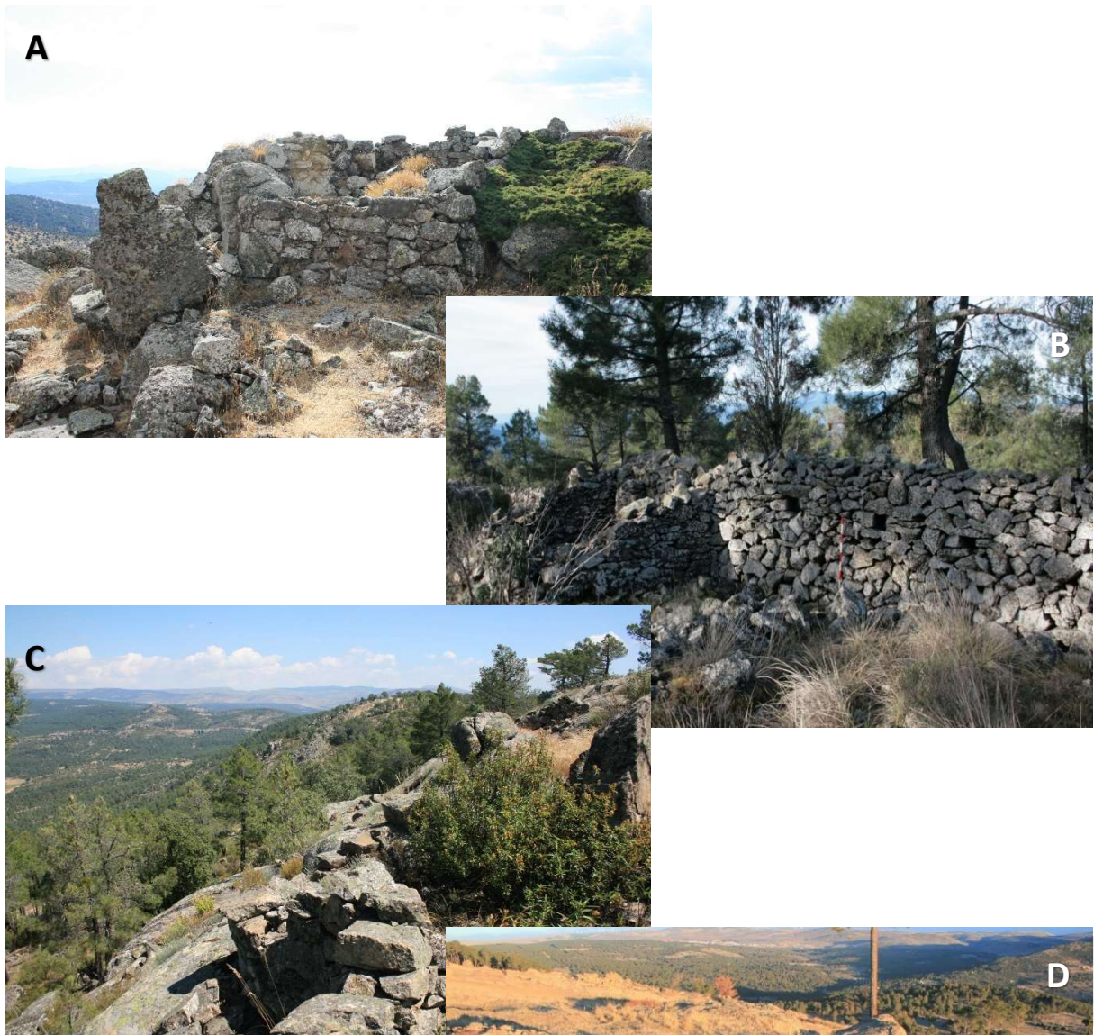
Figura 153. Fortines rectangulares. A) San Benito Bajo (SBB-011: SMA/r): Obra de mampostería careada, principalmente a hueso, aunque presenta zonas con mortero pobre de cemento y arena. Se apoya sobre el roquedo, que forma la pared de su cara sur. Contaba con dos estancias. B) Muro Largo (MLG-008: SMA/r): Fortín rectangular de mampostería a hueso que se apoya en el parapeto principal, aspillerado y con más de 750 m. Presenta una segunda estancia anexa. C) El Turrat (TRR-002: VMQ/n): Fortín básico de mampostería a hueso, encastrado en el parapeto. D) Las Posiciones (POS-004: VMQ/n): Fortín de mampostería a hueso, con unas dimensiones de 3,90x2,85 m. Está muy cubierto por la vegetación. (N.A.).- Aunque el estado de conservación de la obra es malo, se interpreta como fortín y no como alojamiento de tropa por su ubicación; ya que es la obra más avanzada, ante el enemigo, de toda la posición.
