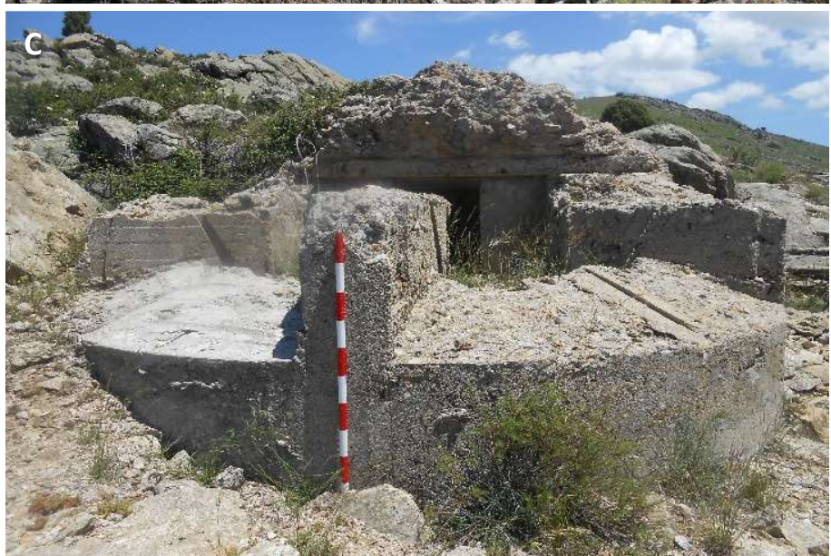
Figura 125. Nidos con forma en D (tipo I CE). A) La Cereda (LCE-001: SMA/r): Obra en hormigón. De 5,37x 3,50 m que presenta tronera frontal doble (con dirección de tiro ONO y OSO) y acceso lateral en codo y a la que falta el techo. Su grado de conservación es del 60 %. Presenta una inscripción en la cámara de fuego, bastante picada, que parece poner "Nº. 1, 3ª Cía.". B) La Cereda (LCE-007: SMA/r): Emplazamiento con tronera a 320º. Acceso a través de pasillo blindado que comunica con la trinchera. Al N del N/A hay un grueso muro de mampostería, de varios m de ancho que protege la trinchera. C) La Cereda (LCE-023: SMA/r): N/A realizado en encofrado de hormigón, con tronera frontal doble, acceso lateral en codo y escalera tallada en la roca. Falta el techo, pero la obra se halla conservada en un 70 %. Todos los ejemplos, corresponden al modelo del I CE del Ejército Popular de la República.
