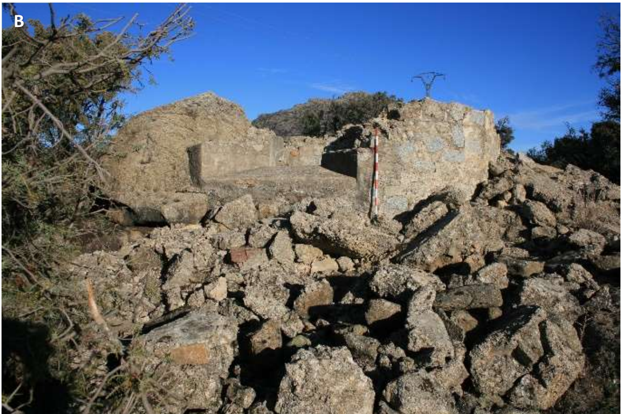
Figura 118. Emplazamientos de morfología circular (tipo 108 BM. de Los Lavajos (LAV-003: RCH/r). A) Obra de mampostería con cemento y hormigón, juntas llagueadas, doble tronera frontal y planta circular de 5,50 m de \varnothing . El techo, desaparecido, estaba soportado por carriles. Se trata de un modelo habitual de la 108 BM. B) Detalle de una de las troneras frontales. Para su enmascaramiento aprovecha los “bolos” graníticos del entorno; así, la separación entre las dos troneras está apoyado en un gran “bolo”.
