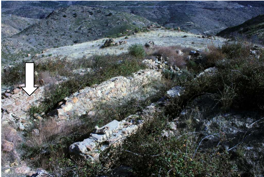
Figura 192. Trinchera nacional revestida, de trazado recto. A) Valdemaqueda 3 (VM3-013: VMQ/n): Trinchera excavada y sujeta con mampostería con muy poco mortero de cemento. Presenta una altura media de 1-1,20 m y tiene una longitud de unos 45 m. Se sitúa en las proximidades del barracón central del CoDe. Como se observa en la fotografía, todo el recinto está ocupado por zarzas y jaras, siendo éste uno de los principales problemas para poder clasificarlas.
