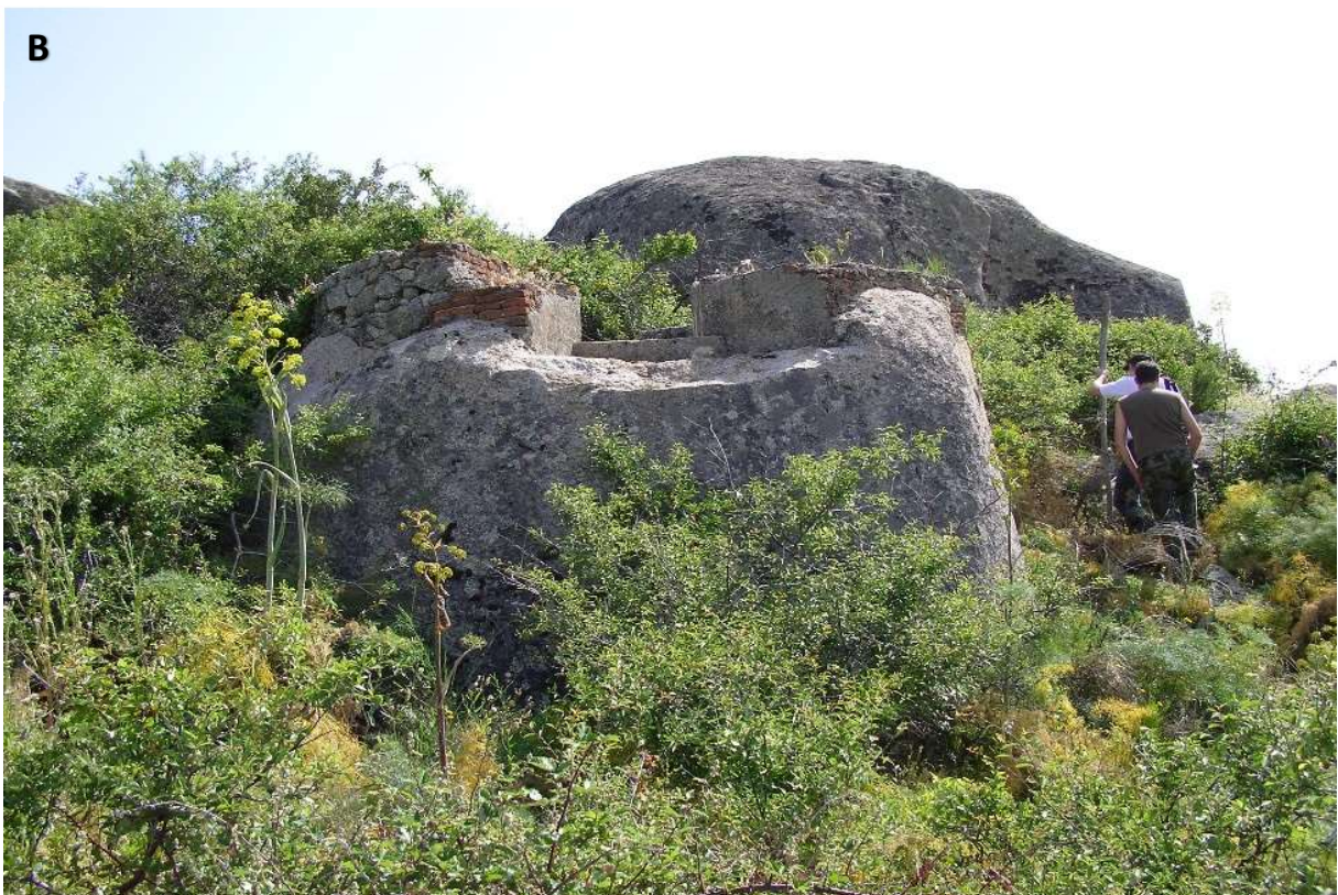
Figura 127. A) La Corbera (COR-015: SMA/n): Asentamiento de 2,80x2,10 m, con una tronera orientada hacia N320 y una forma exterior que no es fácil determinar, dado el mal estado de la obra. En el interior, el frontal de la cámara de combate es hexagonal. Conservado hasta el arranque de la tronera, aproximadamente un 50 % del total. B) Fuentelámpara (FLP-002: RCH/r): N/A poligonal de encofrado de hormigón y ladrillo con enfoscado de cemento. Presenta dos troneras con sus respectivos apoyos para la máquina. La obra se apoya sobre un bolo granítico, con lo que obtiene un buen campo de tiro. Posible obra del 5º Regimiento o muy temprana, con escasa difusión.
