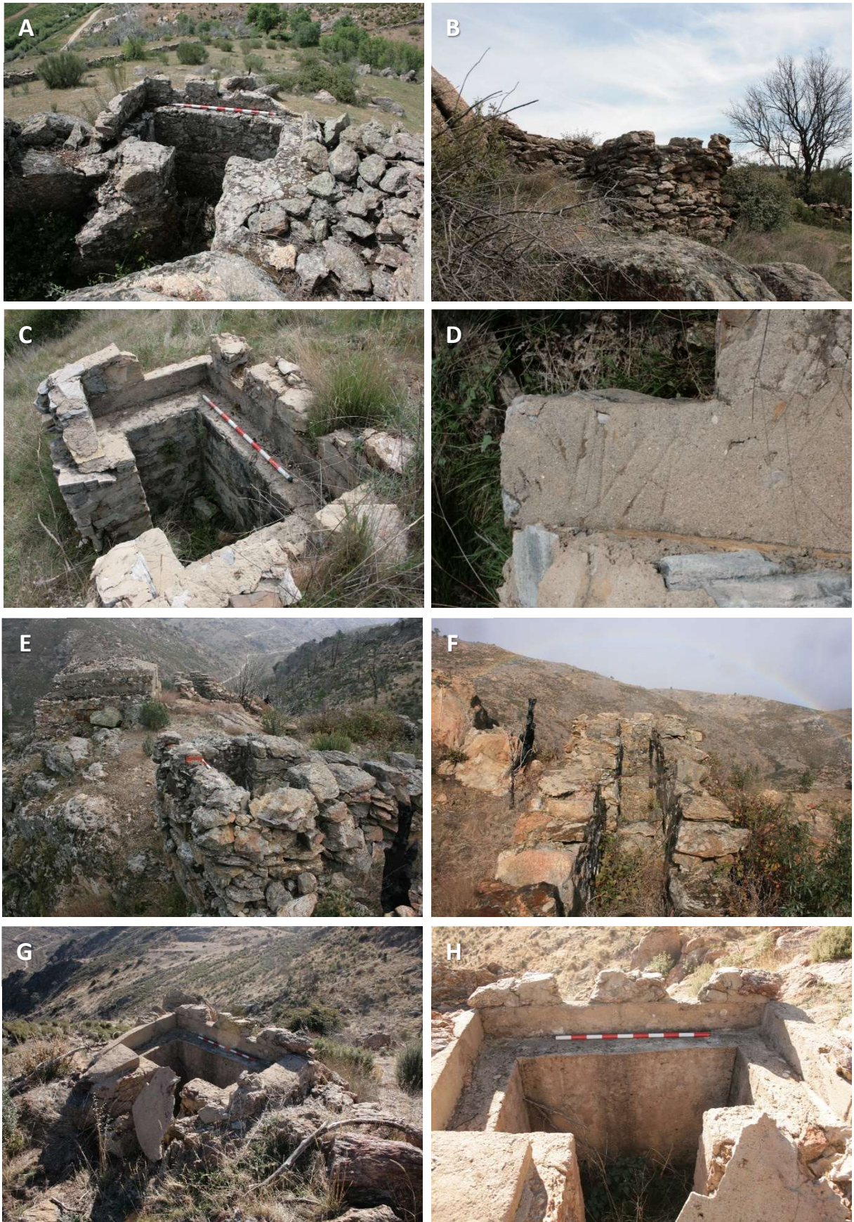
Figura 105. Puestos de tirador en T, asociados a reductos compuestos por obras estandarizadas. Todos están contruidos con mampostería y mortero de cemento, presentan repisa para apoyar el arma automática y cuentan con aspilleras para el fusil. A) Peña Mocha Baja (PMB-006: SMA/n): PT de 1,40x0,80 m y 2 aspilleras. Con acceso por la parte trasera y se conecta al sistema mediante una trinchera aérea. B) Vista del anterior PT desde el exterior del recinto fortificado. C) Valdemaqueda 1 (VM1-007: SMA/n) PT de 1,25x0,70 m (interior) y 4 aspilleras, dos frontales y una a cada lateral. Acceso por la parte trasera, situándose al final de una trinchera aérea en relieve. D) En la parte occidental de la repisa, junto a la entrada, se observa un grafito que dice "VIVA" (ver círculo en fotografía C). E) Valdemaqueda 2 (VM2-003: SMA/n): PT de 1,35x1,05 m (interior) y 2 aspilleras frontales de ladrillo. Acceso por la parte trasera, comunicándose con una trinchera aérea en relieve.
