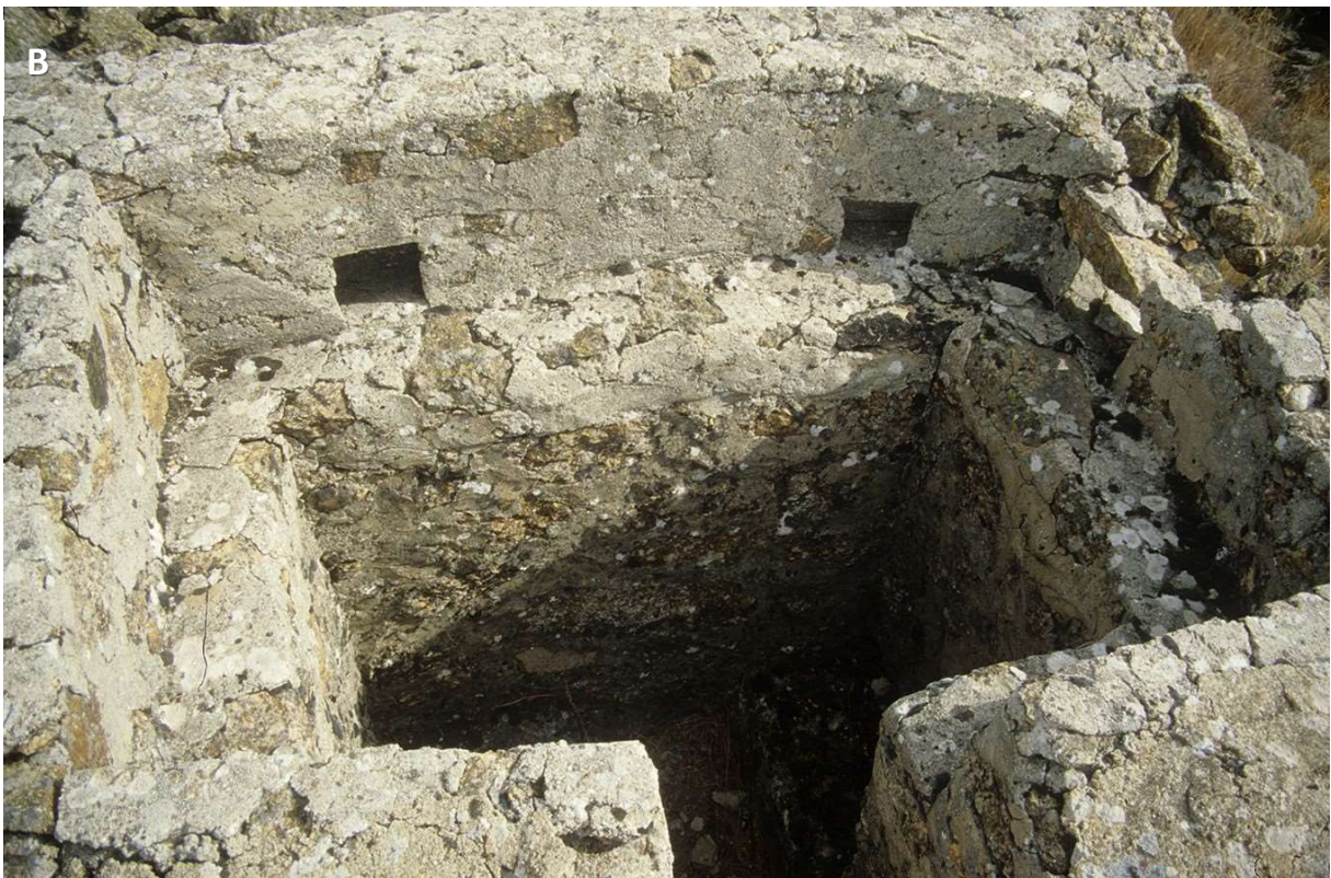
Figura 103. Ciudad Prohibida (CPH-011: SMA/n): A) PT en T blindado, de 2,20x1,80 m (exterior), con aspillera frontal doble para fusilería y otra a cada uno de los otros dos lados. Mampostería con mortero de cemento y acceso trasero por trinchera en relieve mediante una escalera. B) Detalle del interior con la típica forma en T. Podría haber tenido cubierta, aunque no se observan restos.
