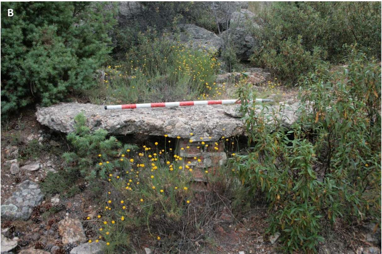
Figura 124. Nido en forma de D (s.l.) de Muro Largo (MLG-029: SMA/r): A) Obra con cámara rectangular blindada (0,60 m de espesor) y frontal en D, con dimensiones de 3x2,15 m. B) Presenta tronera frontal doble y nariz de ladrillo.
