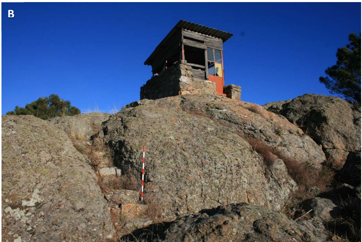
Figura 41. Observatorio de Atalaya (ATY-011: VMQ/n). A) Obra cuadrangular en alto, 4x3 m, construida sobre una roca con mampostería y mortero de cemento. Ha sido transformada en una caseta de vigilancia antincendios. B) Se accede por una escalera rústica, de peldaños.
