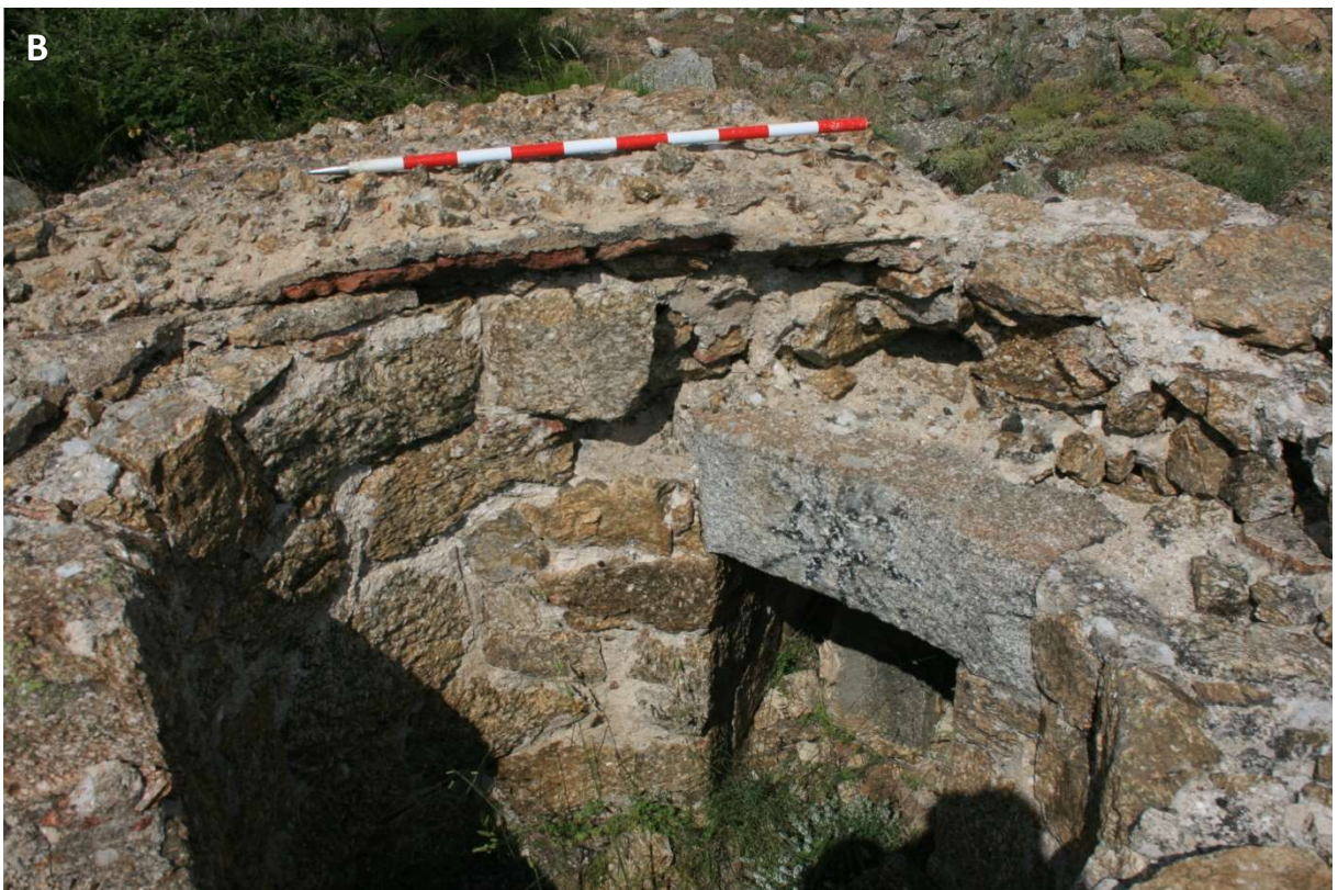
Figura 46. Observatorio de Las Mesetas-Navalespino (NVS-013: SMA/r). A) Obra circular (2,30 m de \varnothing ) de sillares de granito con cemento, acceso trasero a trinchera de fábrica y puerta con dintel. B) Presenta una tronera y vestigios de techo blindado, al estilo de los Fortines del 5º Regimiento. La obra, que se encuentra en bastante buen estado, ha sufrido actos vandálicos (en forma de grafitis).
