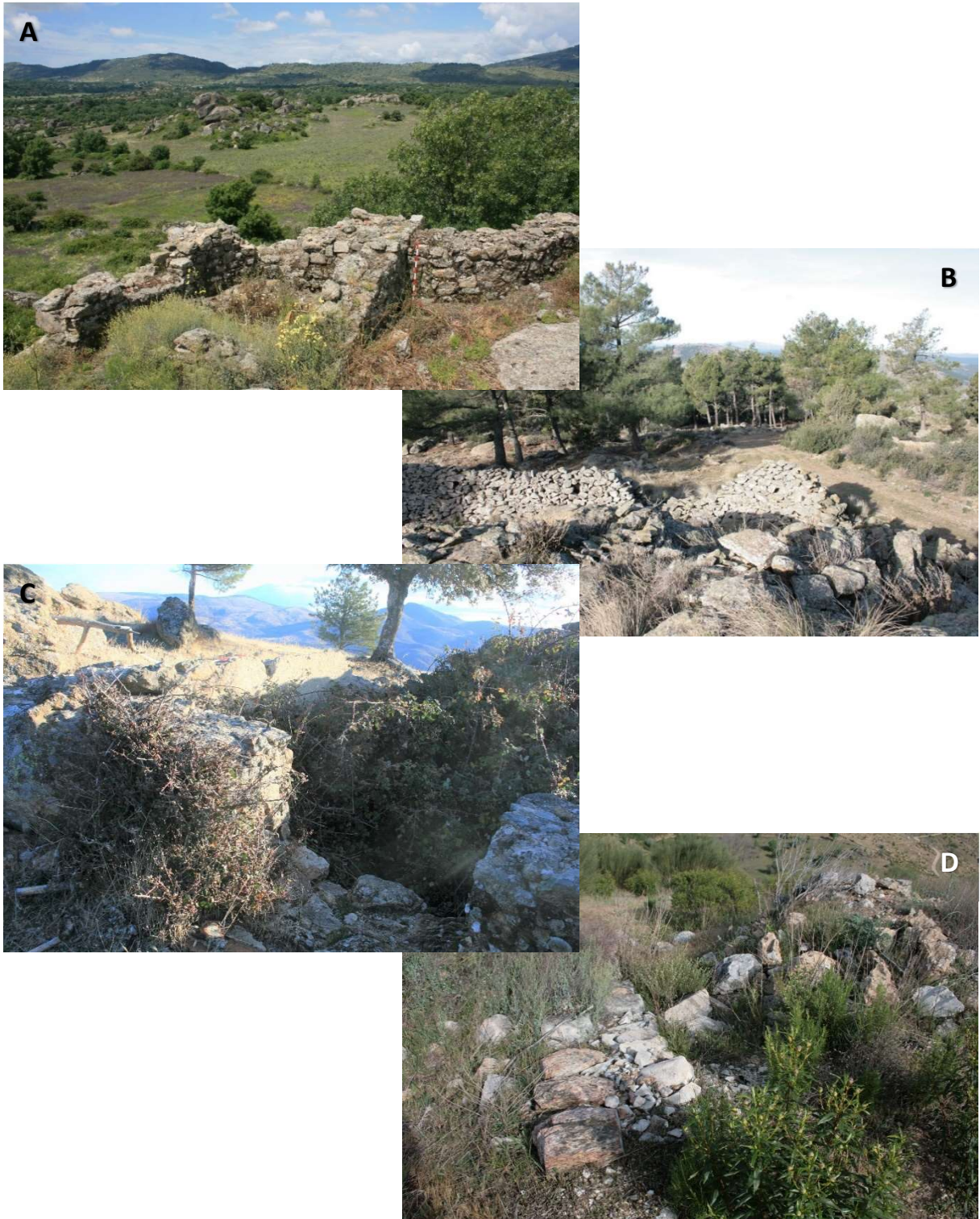
Figura 151. Fortines cuadrangulares. A) Los Picoruchos (PCH-015: RCH/r): Obra de mampostería de granitoide con mortero de cemento, de 3,55x3,47 m. Adosado a un tramo de parapeto construido entre las rocas, presenta dos troneras abiertas hacia el O y el NO. B) Muro Largo (MLG-038: SMA/r): Fortín de mampostería de gneis en seco, de 3,20x3 m., se apoya en el parapeto principal y su entrada se orienta hacia el ESE. C) Atalaya (ATY-002: VMQ/n): Fortín de pequeñas dimensiones, 3,40x2,60 m, construido con mampuestos de gneis trabados con cemento y enfoscado en su interior. La estancia principal se encuentra y presenta la estancia partida por un muro hormigonado. D) Pilón (PIL-040: SMA/n): Posible fortín, de gruesos muros de mampostería con mortero de cemento, ligado a la posición mediante una trinchera excavada de 40 m. Debía de ser de grandes dimensiones, por el área afectada de escombros (22 m 2 ). (N.A.).- Aunque la identificación no es fácil, dado su estado de conservación, se considera que se trata de un fortín. Primero porque ese elemento no existe en la posición y si existe un N/A y, en segundo lugar, si se tratara de otro N/A quedaría en una posición muy expuesta, dado su alejamiento con respecto al centro de resistencia.
