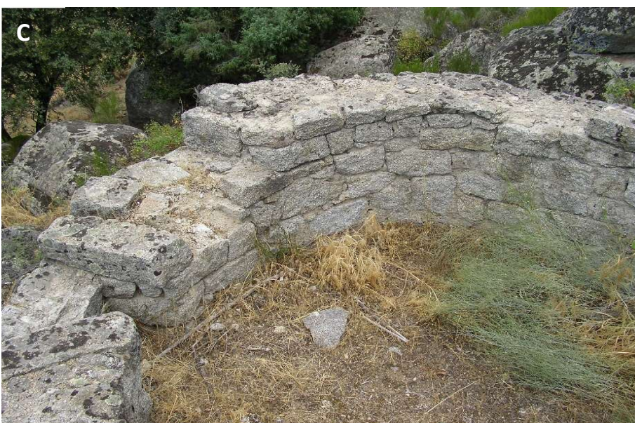
Figura 161. Fortines 5º Regimiento circulares-I. A) Escalante (ESC-005: RCH/r): Obra de 5,50 m de \varnothing , de sillarejo de granitoide con mortero de cemento y acceso orientado hacia el E. Presenta 3 troneras frontales y 1 aspillera, y en su interior se encuentran restos del techo blindado. Situado en el vértice más noroccidental de un conjunto fortificado con un parapeto perimetral, de mampostería y aspillerado (tipo 5º Regimiento). B) Fuentelámpara (FLP-001: RCH/r): Fortín de 6,50 m de \varnothing , levantado sobre un antiguo torreón medieval. De construcción muy cuidada, con un uso abundante de sillares y sillarejos graníticos, muy bien labrados y trabados con mortero de cemento, presenta 26 aspilleras y 6 troneras. El acceso se hace mediante puerta adintelada, con un gran cargadero, orientada hacia el OSO. La cubierta, blindada con hormigón y ladrillo, fue volada y sus restos están en el interior. Posiblemente sea uno de los mejores fortines de la Comunidad de Madrid y el mejor de la serie del 5º Regimiento. C) Matarrubias (MTR-008: RCH/r): Obra bien trabajada, con sillarejos graníticos escuadrados, y que presenta unas dimensiones de 4,50 m de \varnothing , En la fotografía se observa, nítidamente, una tronera de arma automática.
