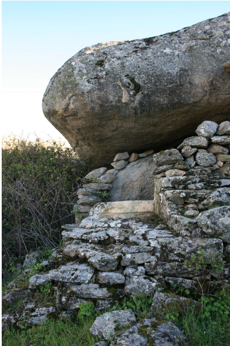
Figura 130. Los Morros (LMR-028: RCH/n): Nido de ametralladora semicircular, blindado, con tronera frontal y construido bajo una roca. La cueva natural se ha cerrado con una pared de mampostería con mortero de cemento, donde se abre una amplia tronera trapezoidal. La pared está parcialmente desplomada y se ha perdido media tronera.
