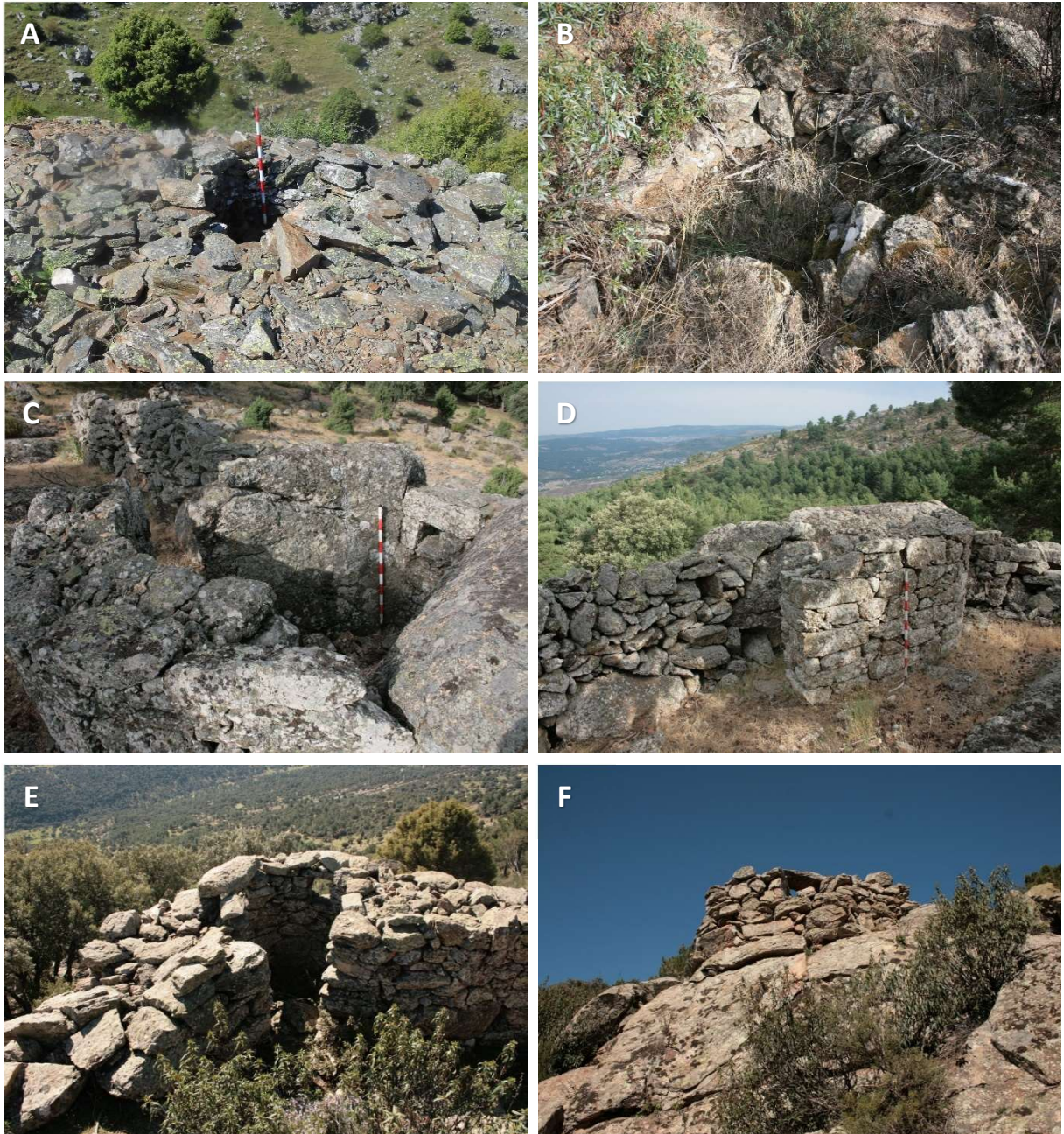
Figura 98. Puestos de tirador circulares (bando republicano), levantados en mampostería a hueso. A) La Cereda (LCE-022: SMA/r): PT de 0,50 m de \varnothing y 0,80 m de profundidad, unido por la gola al parapeto mediante trinchera trasera (prácticamente cegada). B) Cerradero del Guerra (CDG-004: VMQ/r: PT semienterrado. C) Muro Largo (MLG-022: SMA/r): Puesto de tirador de 1,30 m de \varnothing y 1,50 m de altura, cuenta con dos aspilleras orientadas hacia el O. D) El PT anterior está reforzado con un parapeto de mampostería a hueso de 25 m de largo y un espesor de 0,50 m. E) Robledillo-S (RBS-005: RCH/r): PT de entre 0,60-0,75 m de \varnothing . Está integrado en el parapeto blindado que protege al Fortín 5º Regimiento RBS-004, junto con otros 6 PT's. F) Vista del PT anterior sobre el roquedo circundante, mostrando la visibilidad de la que dispone.
