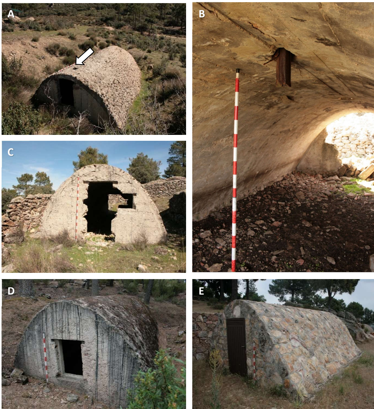
Figura 88. Catenarias rectangulares, realizadas con encofrado de hormigón. A) Casilla (PCA-003: SMA/n): Semienterrada, 6,75x3,80 m. Presenta puerta delantera abierta hacia el SE y ventana contrapuesta, hacia el NO. El techo está alquitranado y cubierto de piedras, para mimetizarlo con el paisaje. Presenta un orificio redondo para la salida del tiro de la estufa, en el extremo NO. B) Ciudad Prohibida (CPH-033: SMA/n): De 8x4,50 m, presenta un tramo de la chimenea de hierro que serviría para calefactar la pieza. C) Ciudad Prohibida (CPH-050: SMA/n): Modelo, de 8x4,30 m, que presenta puerta y ventana lateral en ambos lados. Los marcos han sido arrancados para reutilizarlos (acción antrópica). D) Ciudad Prohibida-N (CPN-013: SMA/n): De 3,40x2,30 m, muestra perfectamente los goterones del techo alquitranado en las paredes correspondientes a los vanos. E) El Encinar (ENC-001: RCH/n): De 6,90x4,60 m, está parcialmente transformada por sus actuales propietarios, que la han forrado de piedra y le han puesto una manta de asfalto en el solado. Presenta puerta principal orientada al NO y ventana al SE de chapa.
