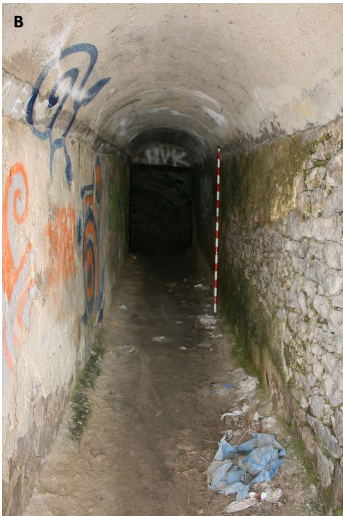
Figura 219. Polvorón del Puerto de la Cruz Verde (PCV-001: SMA/r): A) Polvorín subterráneo, posiblemente de artillería, con un pasillo de entrada de más de 10 m de longitud y 2 m de ancho y alto. La cámara principal es una habitación rectangular de mampostería con mortero de cemento de 8x5 m, muy bien acabada y con una bóveda curva de hormigón armado que, aunque con humedades, parece encontrarse en buen estado. El lugar ha sido utilizado como establo, almacén, etc. B) Vista del interior del fortín
