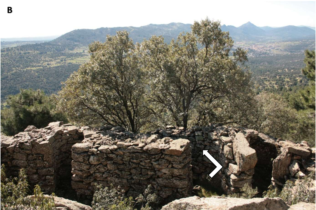
Figura 209. Accesos a posición en clavícula, en el bando republicano. A) Muro Largo (MLG-001: SMA/r): Acceso al parapeto compuesto por dos muros paralelos de mampostería con cemento, dejando un estrecho pasillo de unos 60 cm (puerta en clavícula). El parapeto tiene una anchura de 1-1,10 m y una altura media de 1,70 m. B) Robledillo-S (RBS_024: RCH/r): Acceso al parapeto compuesto por dos muros paralelos de mampostería a hueso (acceso en clavícula), dejando un estrecho pasillo vigilado por los PT's RBS_018 y RBS_019.
