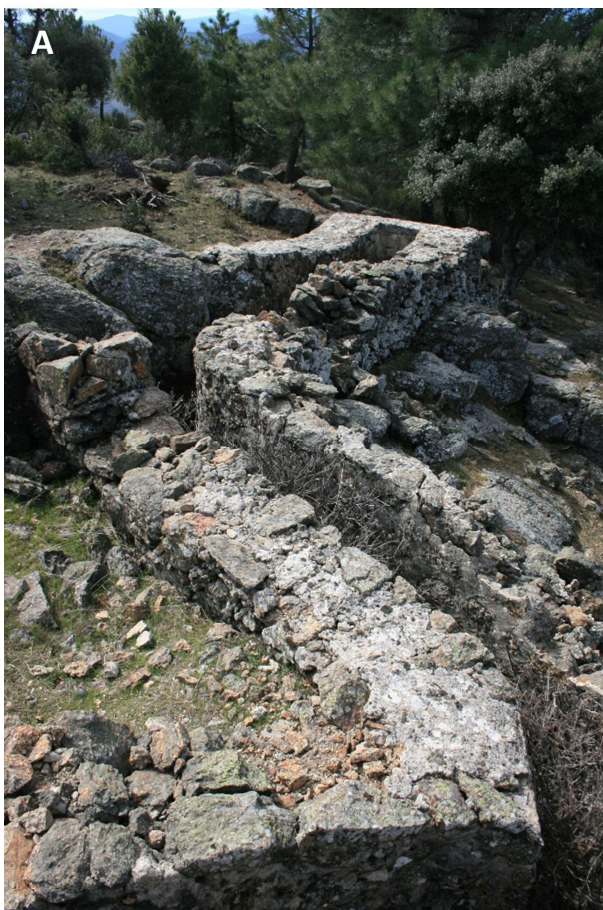
Figura 193. Varios ejemplos de trincheras nacionales en relieve en la Ciudad Prohibida. A) Ciudad Prohibida (CPH_087: SMA/n): Tramo de trinchera en relieve, de mampostería con mortero de cemento y con una anchura de 1 m, una altura de 1,40 m y una longitud de 14 m. Su dirección es N-OSO y comunica con el PT CPH-002. B) Ciudad Prohibida (CPH_089: SMA/n): Tramo de trinchera de mampostería con mortero de cemento, de 19 m y una anchura de 1 m y una altura de 1,40 m. Su dirección es N-S y se comunica con los PT's circulares CPH-019 y CPH-020.
