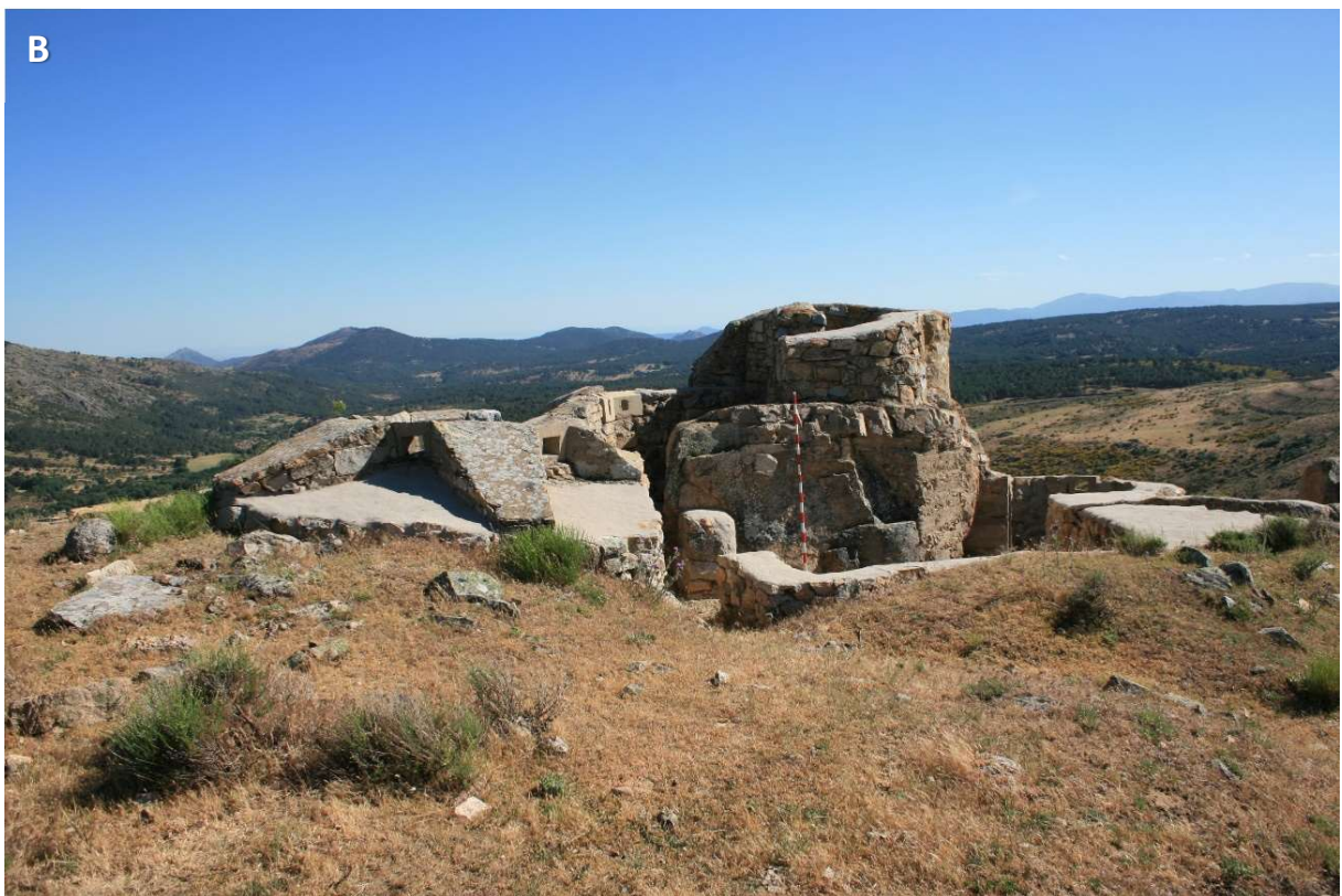
Figura 42. Observatorios de Las Canteras (SMA/n). Se trata de obras de mampostería con mortero de cemento y forma circular. Se trata de un conjunto estandarizado, con 5 islotes de resistencia que han sido restauradas hace una década. Pudieron compartir el uso con el de puesto de tirador. A) LCT-004, presenta 1,20 m de \varnothing y 1,70 m de altura. B) LCT-024, presenta 1,40 m de \varnothing .
