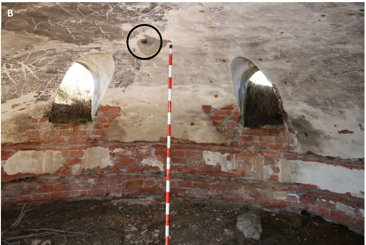
Figura 87. Catenaria circular de Matiazo (MTZ-002: RCH/n). A) Catenaria de planta circular, construida con fábrica de ladrillo e interior enfoscado. Se accedía por una puerta orientada hacia el SE. B) Dos ventanas abovedadas orientadas hacia el SO y el NO. Orificio en el techo para el tiro de una estufa.
