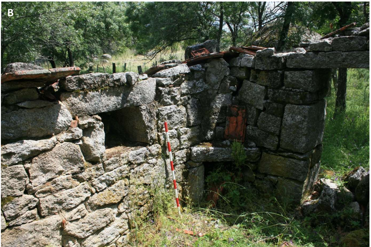
Figura 63. Chabola en Los Picoruchos (PCH-014: RCH/r). A) Refugio de 4,91x4,44 m, donde se aprecia el sistema constructivo (aparejo en seco), así como la puerta y el tipo de cubierta (a dos aguas). B) Detalle de la chimenea, junto a la puerta y de la pequeña ventana.
