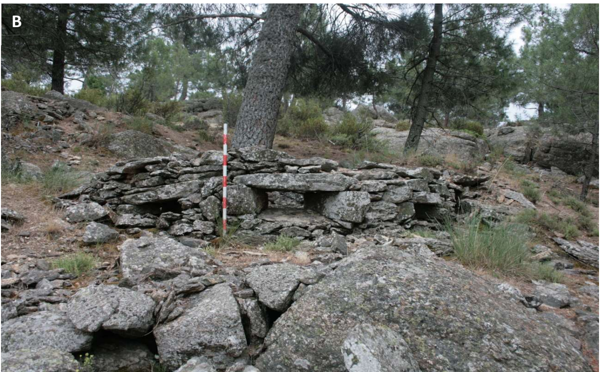
Figura 165. Fortines de la Muerte (MTE-010: SMA/r). A) Pequeño fortín tipo 5º Regimiento, semienterrado y con planta en D. Presenta una cuerda de 3,50 m, profundidad de 1,70 m y muros de mampostería con mortero. B) Cuenta con un nivel de 3 huecos para las armas, 2 aspilleras para fusilería en los extremos y una tronera central para un arma automática. Junto con su hermano, el MTE-011, flanquean al fortín principal MTE-008; por el SO y por el SE, respectivamente.
