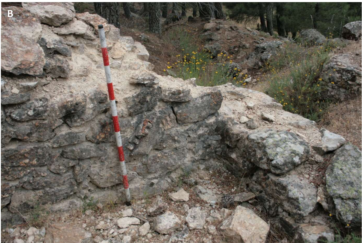
Figura 64. Chabola en los Fortines de la Muerte (MTE-009: SMA/r). A) Obra de 6,20x6,10 m, donde se aprecia el sistema constructivo (mampostería con mortero de cemento) y el tipo de cubierta (a una vertiente). A la izquierda de la fotografía se precia el acceso a la chabola a través de un pequeño pasillo cegado por un bloque de hormigón que, con seguridad proviene de la voladura del techo del vecino fortín tipo 5º Regimiento (MTE-008). B) Detalle del hueco de la chimenea y del arranque de su cobertera (fábrica de ladrillo).
