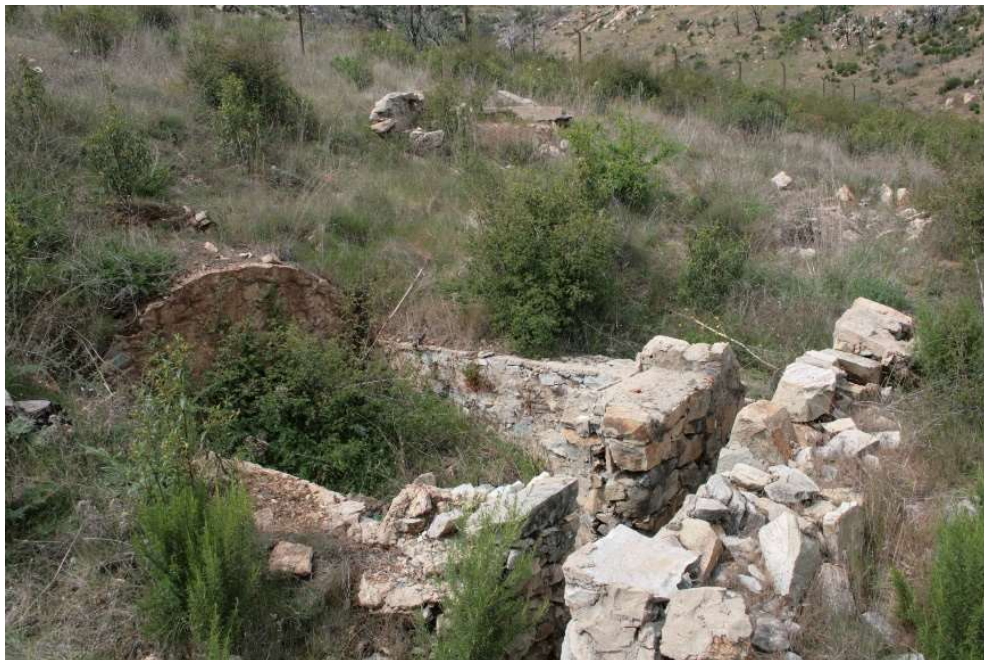
Figura 77. Barracón "estandarizado" de Valdemaqueda 1 (VM1-012: VMQ/n). A) Obra pequeña, 3,65x2,95 m, semienterrada, de mampostería (cuarcita y ladrillo) con mortero de cemento. Presenta entradas en las fachadas NE y SO y un importante frontón. Redondeado. para anclar la bóveda de medio cañón.
