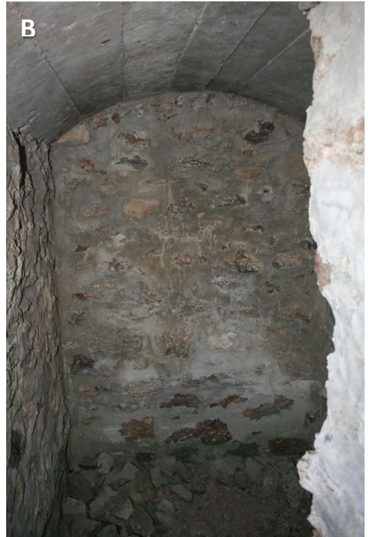
Figura 52. Refugio subterráneo de Valsequillo (VSQ-003: RCH/n). A) Rectangular (3x1,50 m), mampostería con mortero de cemento y acceso desde trinchera en relieve. B) Interior con bóveda rebajada y blindada (encofrado de hormigón).
