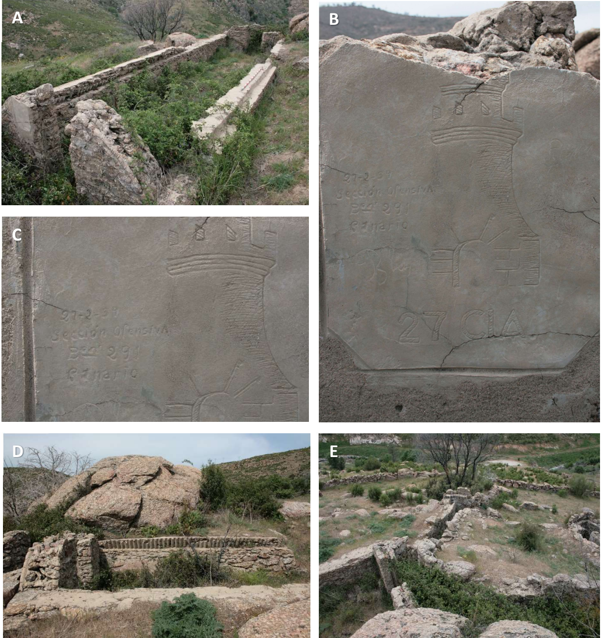
Figura 75. Barracón nacional "estandarizado" de Peña Mocha Baja (PMB-010: SMA/n). A) Detalle de la obra, de mampostería con mortero de cemento y bóveda de medio cañón, con unas dimensiones de 11,50x3 m. Presenta dos entradas, opuestas, en las fachadas NO y SE y, en el dintel izquierdo de la puerta SE, aparece una placa de cemento. B) Placa de cemento, de 0,80x0,60 m, con el escudo del arma de Ingenieros y la inscripción: "27-2-39. Sección Ofensiva. Bon 291. Canario. 27 CIA", en el dintel izquierdo del barracón. C) Detalle de la inscripción. D). Imagen de la impronta que deja en el muro la chapa corrugada, de la cubierta (desaparecida) del barracón. E) Este conjunto defensivo se organiza en torno a este barracón central y, perimetralmente, se disponen las obras estandarizadas: 2 nidos de ametralladora (N/A's), 7 puestos de tirador (PT's) y trinchera en relieve. Detalle de la trinchera en relieve que lleva a un PT.
