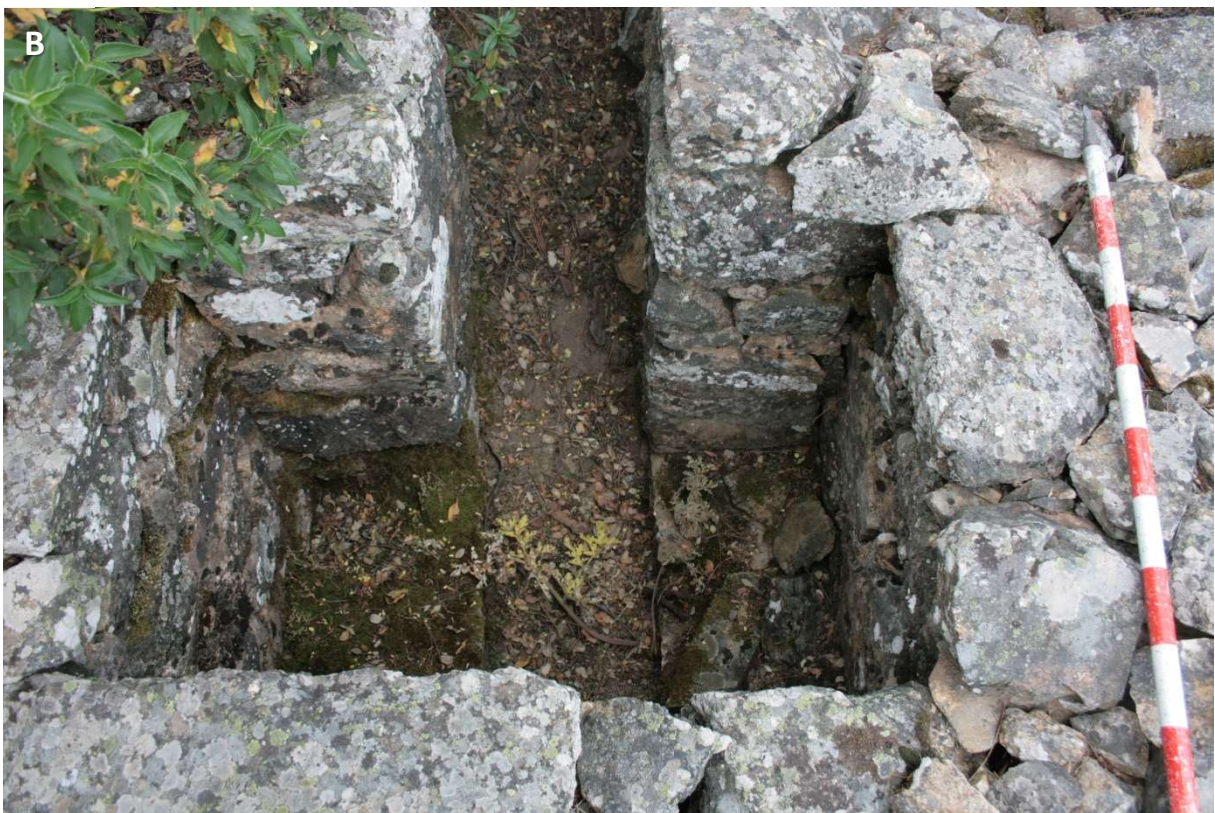
Figura 104. Puestos de tirador en T. A) Casilla (PCA-008: SMA/n): PT de mampostería con mortero de cemento, 0,95x0,45 m, exento y con acceso trasero. Presenta muro curvo, de mampostería con cemento, adosado por el N. B) Ciudad Prohibida-N (CPN-024: SMA/n): PT de mampostería, exento, con acceso trasero y doble banco lateral interior, para el tirador.
