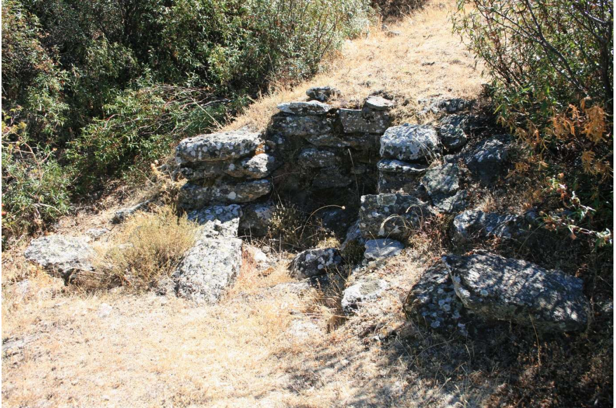
Figura 101. Las Hoyas (HOY-002: SMA/r): PT rectangular de mampostería a hueso, con unas dimensiones de 0,80x0,50x1 m. La profundidad observada de 1 m indica, que o bien hay un relleno de más de 0,50 m o la posición del tirador debería ser de rodillas.
