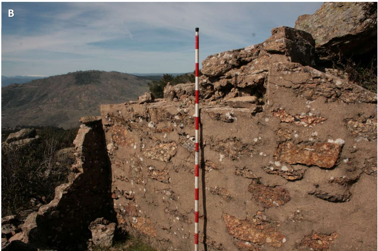
Figura 177. Asentamiento para mortero de Ciudad Prohibida (CPH-034: SMA/n). A) Vista general del asentamiento, en relación con su posición centrada en el CoDe. Obsérvese, en su proximidad, la existencia de una trinchera elevada y una catenaria rectangular. B) Detalle del enfoscado del interior del asentamiento, sobre la mampostería de gneis glandular de la pared.
