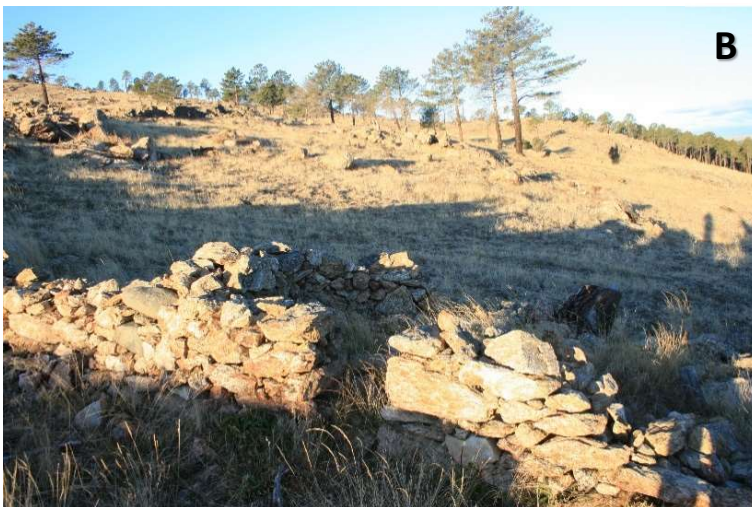
Figura 152. A) Santa Catalina (SCT-007: VMQ/n): Fortín elipsoidal, con un eje mayor casi el triple que el menor (9,10x3,14 m), realizado en mampostería a hueso. Se encuentra al final de un parapeto, también de piedra seca. B) Las Posiciones (POS-008: VMQ/n): Fortín de mampostería a hueso en forma de D, con una cuerda de 4,70 m, que sobresale del parapeto y presenta entrada trasera. Su dirección de tiro oscila entre el NNO-O, justamente la contraria a la que debería corresponderle. (N.A.).- La morfología de la posición y la ubicación de los fortines, así como sus direcciones de tiro, parecen esperar más el ataque desde el N-NO que desde el S, que sería lo esperado, dada la situación de las tropas republicanas. Ello, junto con el sistema constructivo y su aspecto arcaizante, nos recuerdan más a fortificaciones republicanas que a nacionales. Por lo tanto, consideramos que originalmente se habría tratado de una posición republicana, conquistada y reutilizada posteriormente por los nacionales. C) Los Lavajos (LAV-002: RCH/r): Fortín de planta en D, con muros de mampostería a hueso. Está asociado al parapeto aspillerado LAV-001 y presenta una gran tronera frontal orientada al O.
