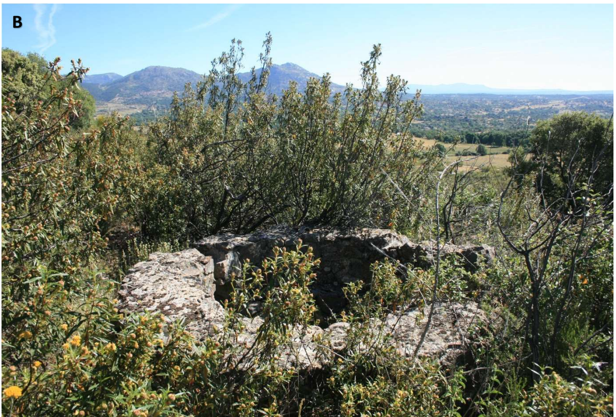
Figura 150. Fortines circulares. A) Muro Largo (MLG-020: SMA/r): Fortín circular de mampostería a hueso, de 4,60 m de \emptyset , y encastrado en el parapeto que aquí es de 1,10 m de espesor y 1,20 m de altura. B) Las Umbrías (UMB-010: RCH/n): Fortín circular de 1,70 m de \emptyset , construido en mampostería de granitoide trabado con mortero de cemento y con 2 aspilleras orientadas al NO/SO. No se conserva la cubierta ni se aprecia arranque de la misma.
