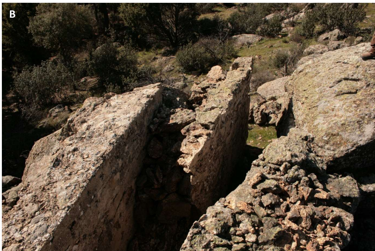
Figura 208. Accesos a posición en clavícula, en el bando nacional. A) La Corbera (COR-020: SMA/n): Puerta o vano en clavícula, en la trinchera en relieve, que da acceso al interior del conjunto defensivo. Presenta una anchura de 0,85 m y está construida en mampostería con mortero de cemento. B) Ciudad Prohibida (CPH-027: SMA/n): Acceso al parapeto, compuesto por dos muros paralelos de mampostería con mortero de cemento. Entre el muro más oriental y la pared del parapeto el espacio esta colmatado por piedras.
