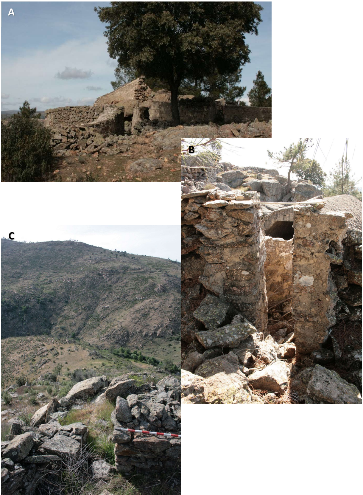
Figura 207 Accesos a posición, por interrupción simple, en el bando nacional. A) Ciudad Prohibida (CPH_069: SMA/n): Abertura en forma de embudo, bastante ancha (0,80 m), aprovechando la situación de dos de los parapetos. Por su estructura y situación podría tratarse de la entrada principal a la posición. B) Ciudad Prohibida (CPH_067: SMA/n): Se trata de una puerta minúscula (portillo) en el parapeto. Tiene una luz de 35 cm. C) Pilón (PIL-034: SMA/n): Discontinuidad en el parapeto, que parece reforzarse con una estructura cuadrada de mampostería, como si fuese un puesto de guardia.
