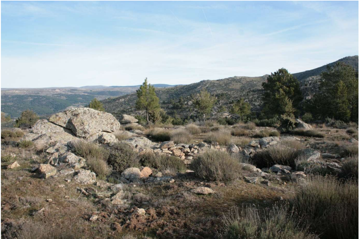
Figura 47. Observatorio de Muro Largo (MLG-012: SMA/r). Construcción rectangular (5,60x2,65 m) semienterrada, de mampostería seca. Presenta una puerta en la fachada meridional, la que da a la trinchera. El problema de este tipo de construcciones, sobre todo en el bando republicano, es que solían tener una doble utilidad, observación y alojamiento de la tropa que lo servía. A pesar de su mal estado creemos en ese doble uso, dado que es la construcción situada en el punto más elevado de la zona.
