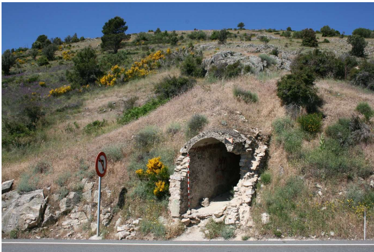
Figura 218: Entrada al polvorín subterráneo del Puerto de la Cruz Verde, ubicado enfrente del mirador Ángel Nieto en la carretera M-505.
