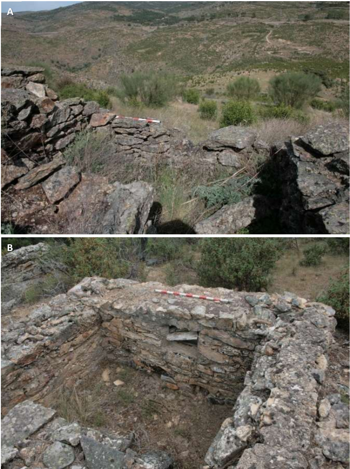
Figura 120. Emplazamientos nacionales de N/A's de forma cuadrangular. A) Pilón (PIL-019: SMA/n): Asentamiento "a barbeta" de 3x3 m, realizado en mampostería a hueso. La tronera, está orientada hacia el E, y está realizada con sillarejos de gneis. B) Ciudad Prohibida-N (CPN-025: SMA/n): N/A semienterrado, de mampostería de gneis y unas dimensiones exteriores de 3,45x3 m. Presenta tronera frontal que conserva el encofrado de madera original, y en la base de ésta se aprecian dos agujeros en el muro para fijar las patas de la ametralladora. Aunque no se conserva, se aprecia el arranque de un techo plano.
