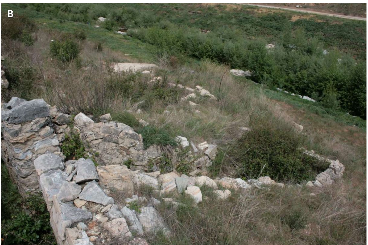
Figura 108. Valdemaqueda 1 (VM1-005: VMQ/n): A) PT en pasillo, de mampostería con mortero de cemento y ligado a una trinchera en relieve y a un conjunto de obras estandarizadas. B) La particularidad de este PT es que el puesto del tirador se corresponde con el final de la trinchera en relieve que le protege. Prácticamente, es un largo pasillo rectangular de unos 5 m de largo por 1,20-1,30 m de ancho y al final del mismo, y junto al río, es donde se ubica el tirador.
