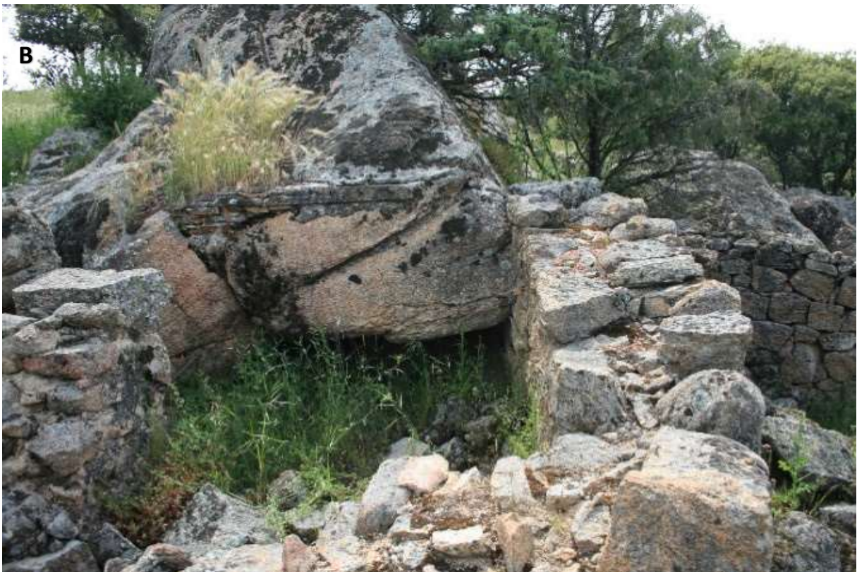
Figura 119. Emplazamientos republicanos de N/A's de forma cuadrangular. A) Escalante (ESC-003: RCH/r): N/A "a barbeta", de mampostería careada a hueso, con sillarejos de granitoide y tronera frontal. Está unido a un parapeto y sus dimensiones son 3,79x3,16 m. B) Escalante (ESC-006: RCH/r): N/A de 3,78x3,54 m, mampostería con mortero de cemento y tronera frontal. Presenta vestigios de techo de ladrillo con cemento.
