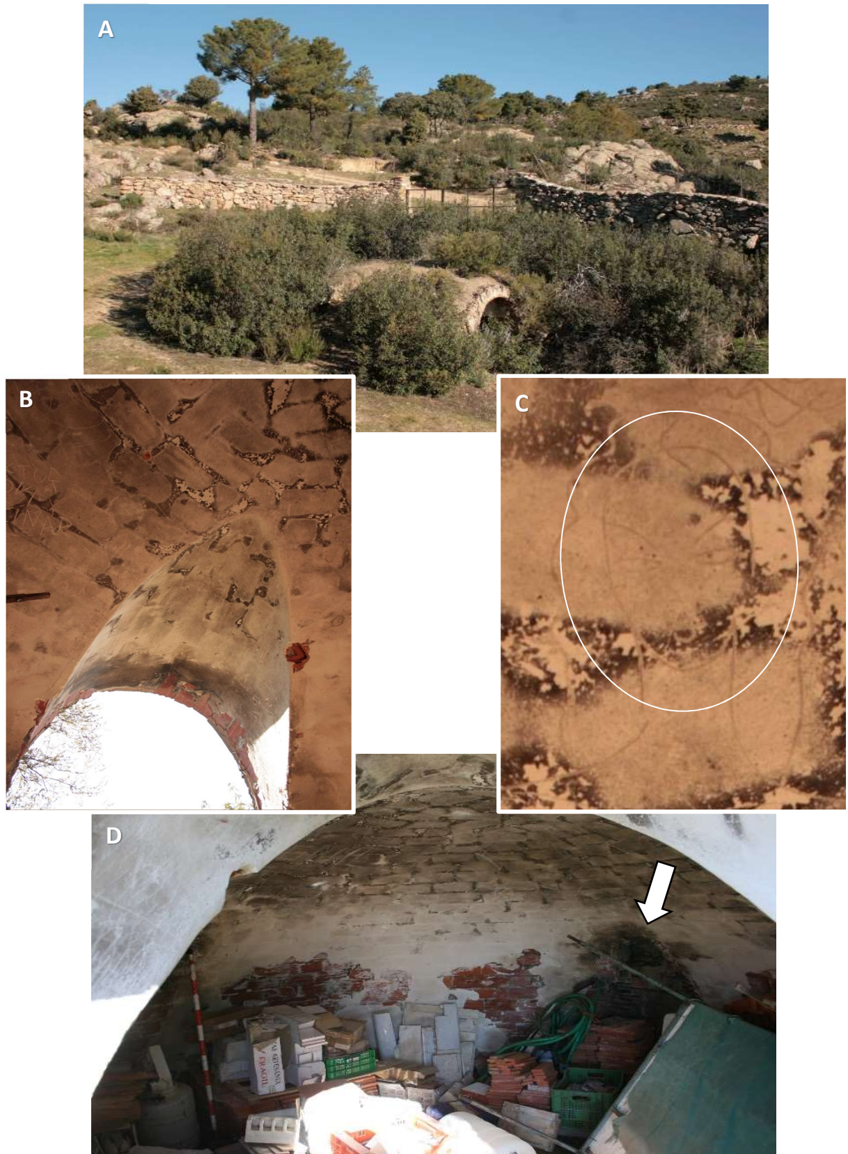
Figura 86. Catenaria circular de Aviñón (AVÑ-001: RCH/n). A) Vivienda catenaria circular de ladrillo, de 3,30 m de \varnothing exterior. El acceso es a través de una puerta abovedada, orientada al ESE. B) Presenta una ventana, también abovedada orientada al SSO. C) En el techo hay un grafiti que representa cuatro mujeres desnudas, colocadas en cruz. Detalle de una de las caras femeninas D) El interior presenta paredes y techo enlucidos con yeso y hay constancia de un hueco, en la pared, para la chimenea.
