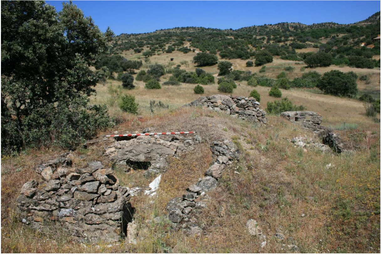
Figura 50. Refugio subterráneo de La Casilla-Entre Arroyos (EAS-005: RCH/n), de forma rectangular (4,5x3 m) y construido de mampostería, con mortero de cemento y techo abovedado y blindado.
