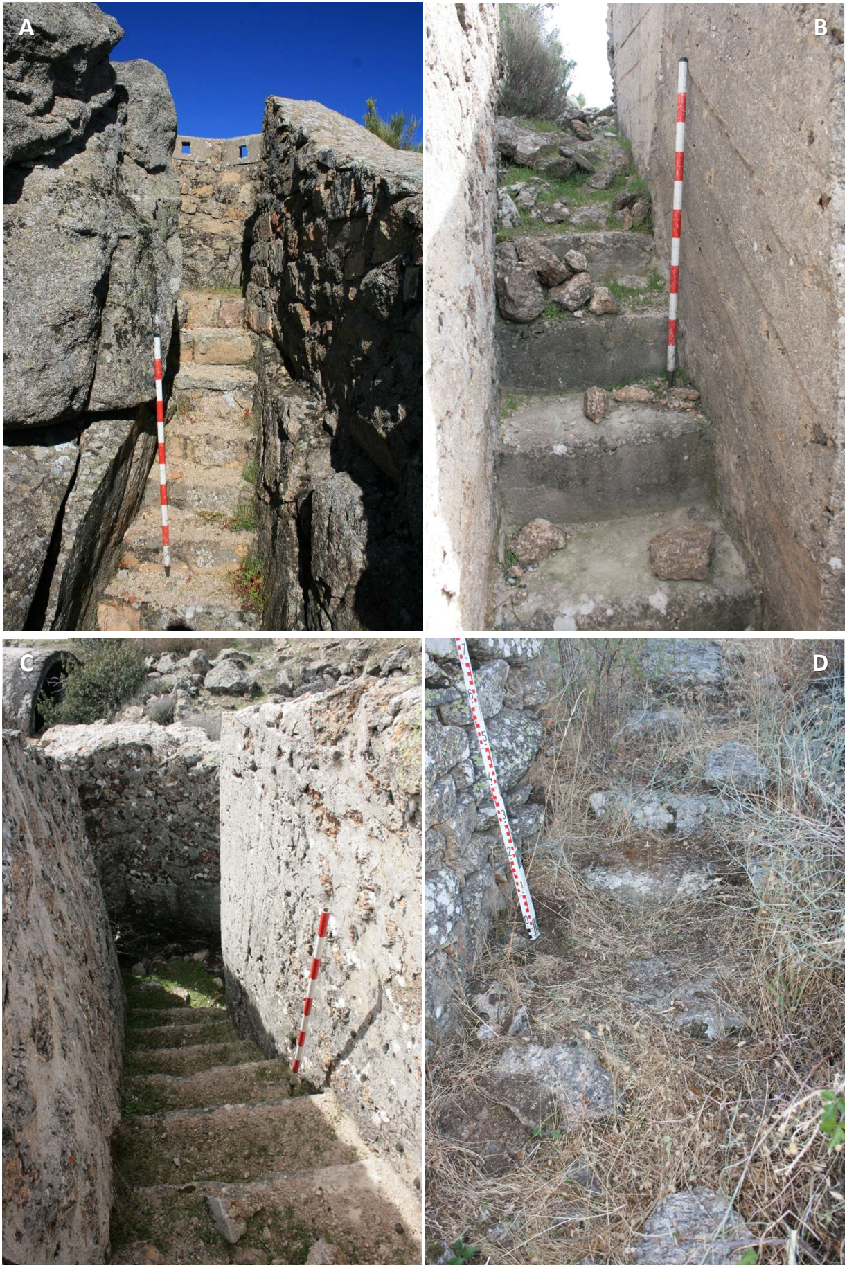
Figura 211. Diversos ejemplos de escaleras. A) Las Canteras (LCT-016: SMA/n): Escalera de mampostería con cemento, de 2 m y 7 escalones, que da acceso desde la trinchera elevada al PT/observatorio LCT-015. B) Ciudad Prohibida (CPH_083: SMA/n): Escalera de cemento, con 5 escalones, que da acceso desde la trinchera elevada al Observatorio CPH-006. Mide 1,80x0,85 m. C) Ciudad Prohibida (CPH_085: SMA/n): Escalera de cemento, con 6 escalones, que da acceso desde la trinchera elevada al PT CPH-014. Mide 1,80x1 m. D) Robledillo (ROB-009: RCH/r): Escalera de lajas de piedra entre las viviendas ROB-008 y ROB-010. Mide 1,60x0,50 m.
