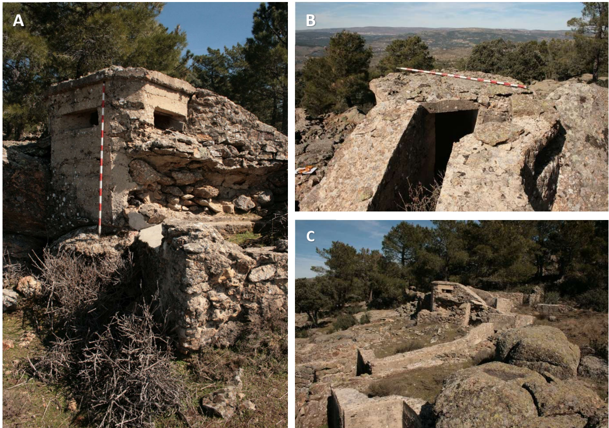
Figura 39. Observatorio de la Ciudad Prohibida (CPH-055: SMA/n). A) Construcción cuadrangular de hormigón de 2,40x2,10 m, blindado, con dos troneras orientadas al NO y SO, tiene adosado los restos de un nido de ametralladora. B) Acceso al observatorio. Obsérvese el gran campo de visión del que dispone y la presencia de rocas sobre el encofrado, para su camuflaje ante la observación aérea. C) El observatorio se encuentra dentro de un complejo que cuenta con diversos elementos defensivos, entre otros, con trincheras en relieve de mampostería con cemento (en primer plano).
