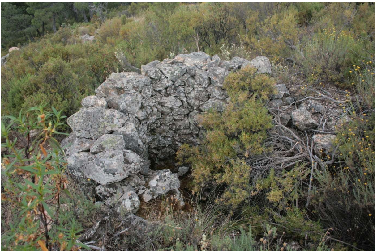
Figura 173. Robledillo-S (RBS-011: RCH/r): Estructura semicircular de mampostería a hueso asociada al fortín RBS-010, unida por una trinchera. Posible pozo granadero de flanqueo.
