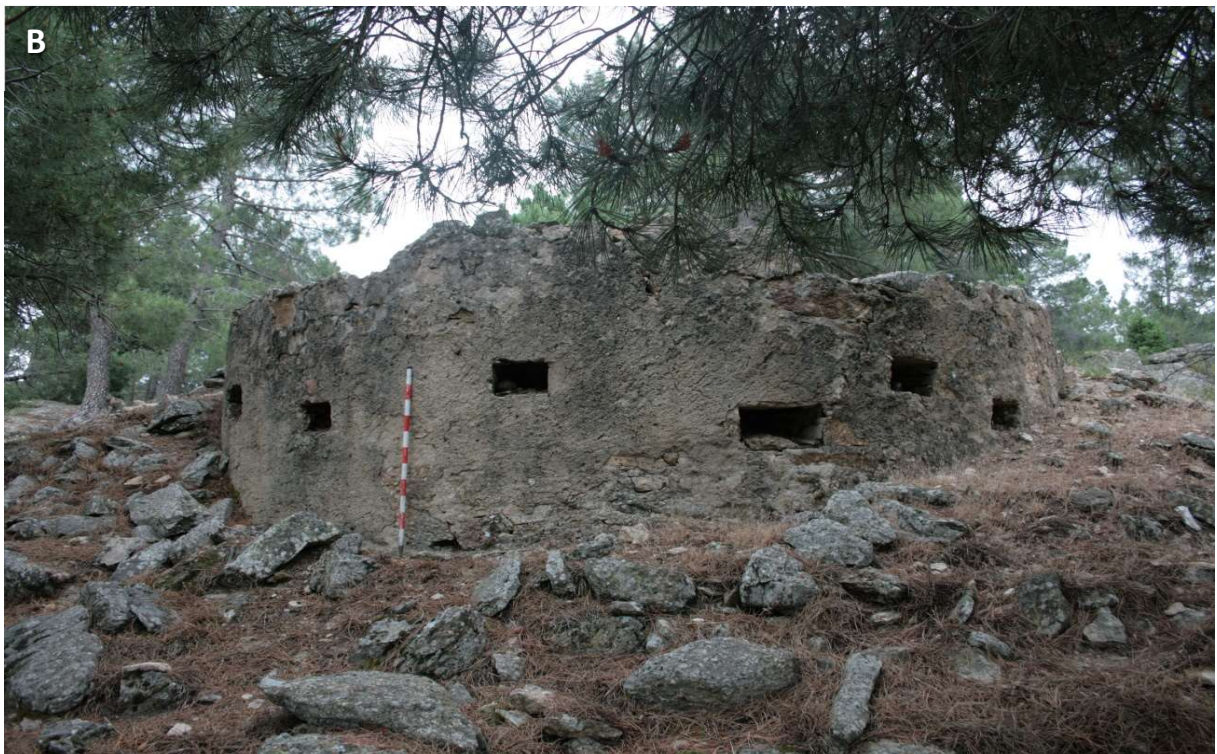
Figura 164. Fortines de la Muerte (MTE-008: SMA/r). A) Fortín tipo 5º Regimiento, observándose perfectamente en la fotografía la traza de la planta en D. B) Presenta sillería con mortero de cemento en el interior, mientras que el exterior aparece enfoscado (ver Fig. 125 B). Presenta dos niveles de huecos para las armas, con tres vanos cada uno. El superior está constituido por 3 aspilleras para fusilería, mientras que, en el inferior, la central es una tronera para un arma automática y las dos de los extremos son aspilleras. No hay rastro del techo, por lo que podría no haberse finalizado o haber sido de rollizos de madera, de uralita, o tratarse de un fortín "a barbata" o, inclusive, guardar los restos del mismo entre el material que lo colmata.
