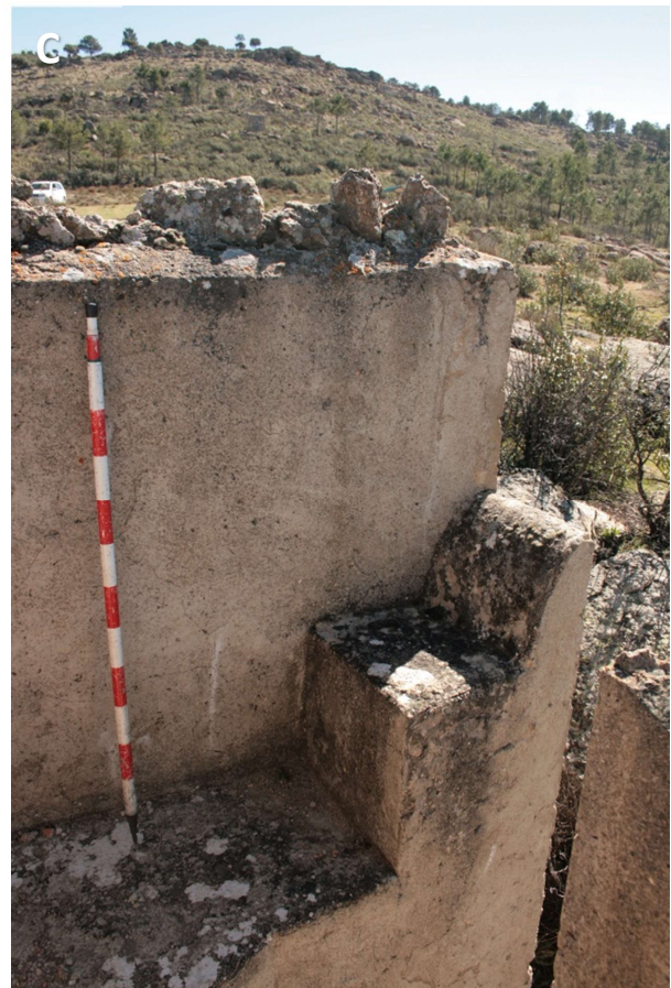
Figura 38. Observatorio de Casilla (PCA-010: SMA/n). A) Obra rectangular de encofrado de hormigón, de 4,30x2,05 m, que se localiza sobre un roquedo de gneises glandulares. B) Acceso mediante escalera de caracol. C) Asiento de fábrica, ¡¡con respaldo!!.
