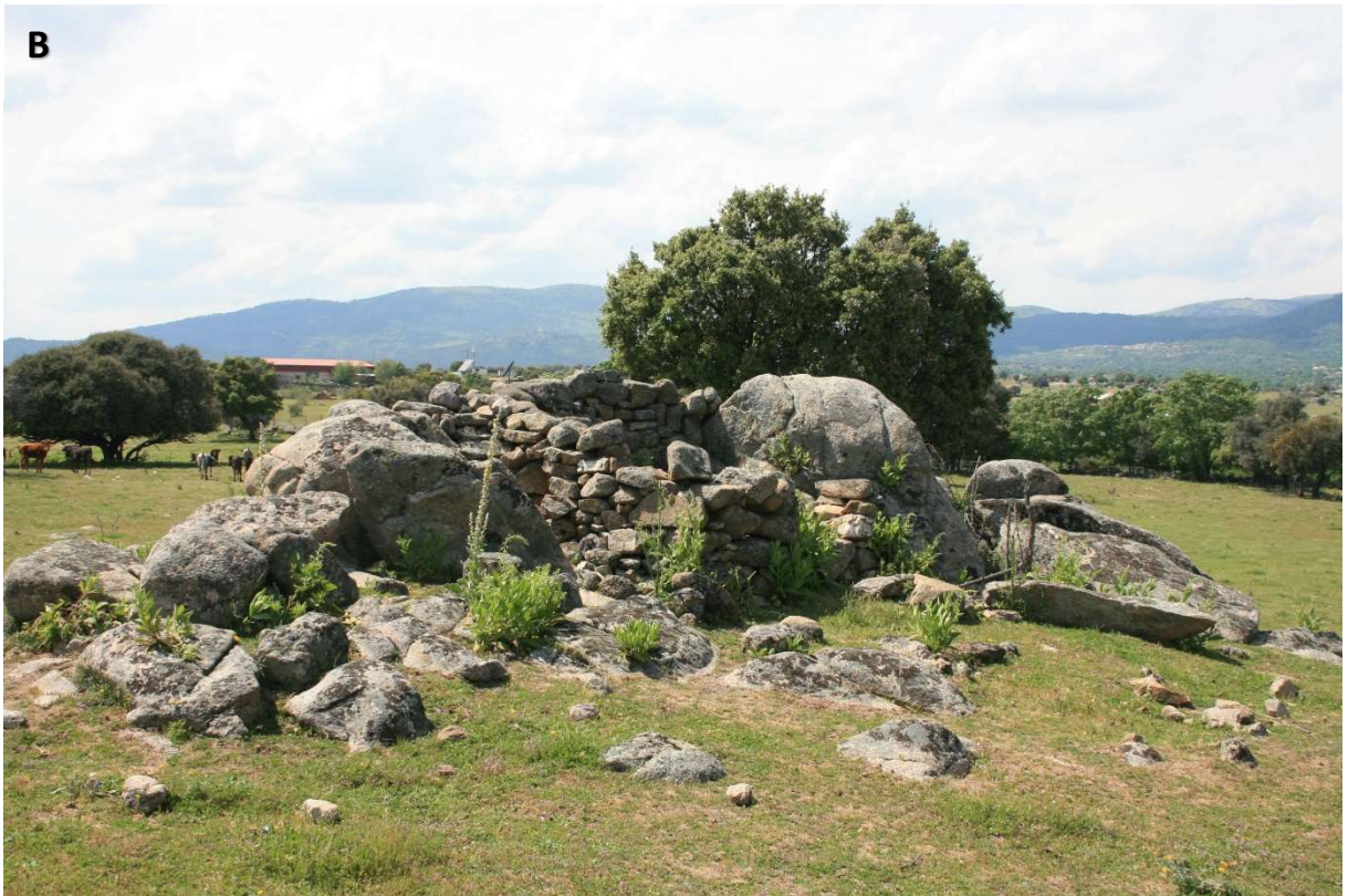
Figura 99. Puestos de tirador cuadrangulares. A) Pilón (PIL-003: SMA/n): PT de mampostería de gneis a hueso, con unas dimensiones de 2,95x2,75 m y dirección de tiro hacia el S. B) Escalante (ESC-001: RCH/r): PT de mampostería a hueso, de 3,02x2,32 m, encastrado entre dos bolos graníticos.
