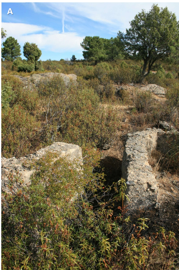
Figura 208. Accesos a posición en clavícula, en el bando nacional. A) La Corbera (COR-020: SMA/n): Puerta o vano en clavícula, en la trinchera en relieve, que da acceso al interior del conjunto defensivo. Presenta una anchura de 0,85 m y está construida en mampostería con mortero de cemento. B) Ciudad Prohibida (CPH-027: SMA/n): Acceso al parapeto, compuesto por dos muros paralelos de mampostería con mortero de cemento. Entre el muro más oriental y la pared del parapeto el espacio esta colmatado por piedras.
