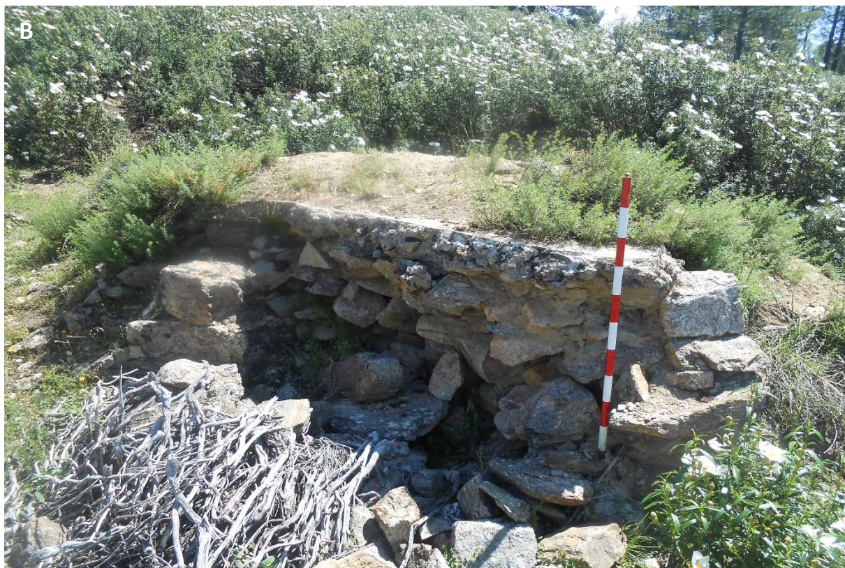
Figura 122. N/A's republicanos, blindados, de forma cuadrangular. A) Cerro Pelado (CPL-002: SMA/r): Obra de mampostería y mortero de cemento, de 4,24x3,90 m, que incorpora ladrillo en algunas partes, como por ejemplo en un pequeño escalón situado donde se encastraría el arma. Se puede apreciar el arranque del techo, que parece plano, y es blindado. Presenta una tronera orientada hacia la Estación de FF.CC. de Santa María de la Alameda y el río Cofio. B) Cerro Pelado (CPL-003: SMA/r): Se trata de una gran obra de dos cuerpos, uno trasero cuadrado y otro adelantado, posible N/A. Techo destruido, aunque se observa el arranque y era blindado. Presenta una dirección de tiro de 210°.
