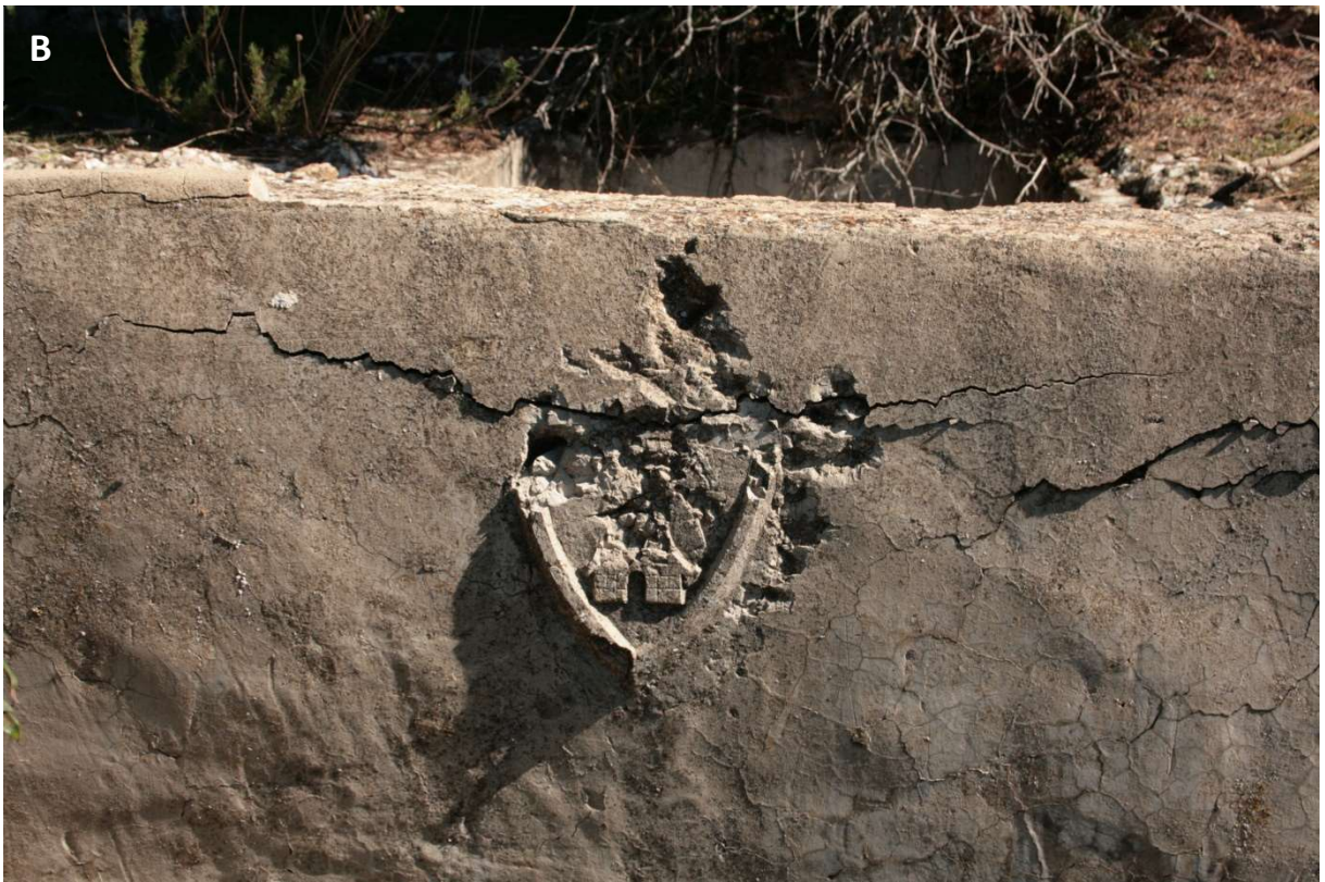
Figura 213. Ciudad Prohibida (CPH-018: SMA/n): A) Fuente compuesta por un vaso de hormigón de 3,50x1,70 m y un depósito, también de hormigón, de 5,20x1,20 m y donde se observa la impronta de la cubierta, a base de carriles de hierro recuperados. B) En el muro de separación entre ambos aparece el escudo de ingenieros, parcialmente destruido, aunque aún se observa la parte basal del castillo.
