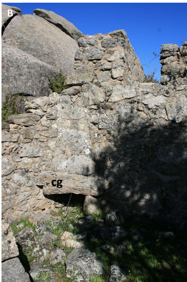
Figura 65. Chabola en Los Morros (LMR-040: RCH/n). A) Chabola de mampostería con mortero de cemento y cubierta a una vertiente. Aprovecha la seguridad de un gran berrocal granítico para su ubicación. Sus medidas son 3,52x2,63 m. B) Detalle de la chimenea, culminada con dos grandes cargaderos graníticos (cg).
