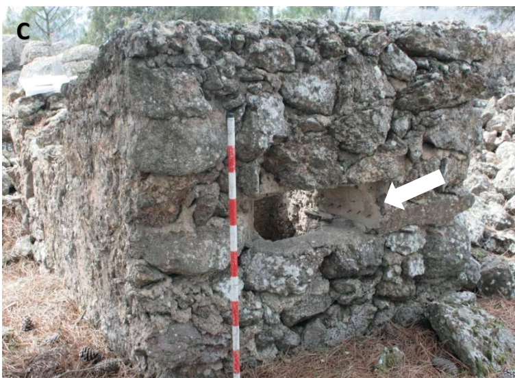
Figura 139. Otras morfologías de A/FA's. A) Valdemaqueda 4 (VM4-011: VMQ/n): Asentamiento en T, de mampostería con cemento, de 1,40x0,50 m (interior). Presenta una tronera de 1 m de anchura (interior) y repisa para apoyar el arma automática. Acceso por la parte trasera. Se sitúa al final de una trinchera en relieve curva y forma parte de un reduto compuesto por obras estandarizadas. B) Ciudad Prohibida (CPH-010: SMA/n): Obra rectangular sin techo de mampostería con cemento y con tronera frontal. Presenta unas dimensiones de 3,35x2,40 m. C) Ciudad Prohibida (CPH-010: SMA/n): Detalle de la tronera frontal.
