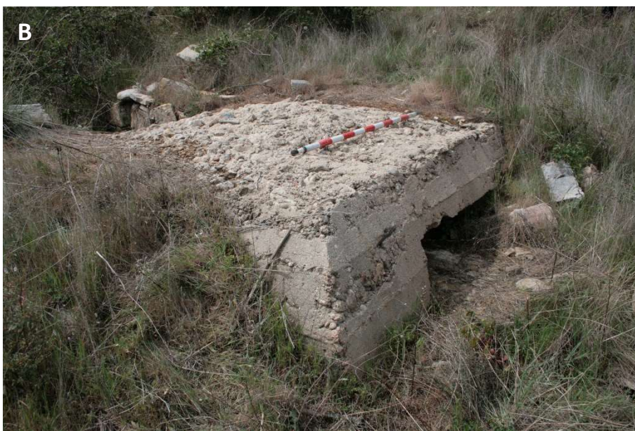
Figura 123. Emplazamientos de forma cuadrangular (tipo Valdemaqueda). A) Peña Mocha Baja (PMB-005: SMA/n): Nido de mampostería con mortero y techo de hormigón armado, de 2,75x2,45 m, cuyo encofrado (antes de fraguar) se tapizó de rocas del entorno para camuflar la obra ante la observación aérea. Interiormente presenta una tronera orientada al NO y banco en T para la máquina, con la inscripción "S. Ofensiba". Su acceso es por trinchera aérea y puerta abovedada y forma parte de un reducto compuesto por obras estandarizadas. B) Valdemaqueda 1 (VM1-003: VMQ/n): Nido de mampostería con mortero y techo de hormigón armado, de 2,50x2,40 m, con una tronera que disparaba hacia el N. Forma parte de un reducto compuesto por obras estandarizadas. C) Valdemaqueda 4 (VM4-008: VMQ/n): Obra de mampostería de 2,30x2,20 m, realizada en mortero y con techo de hormigón armado abovedado. Tronera en dirección NNE. Banco en T en el interior para el arma. Acceso por trinchera aérea y puerta abovedada. Forma parte de un reducto compuesto por obras estandarizadas.
