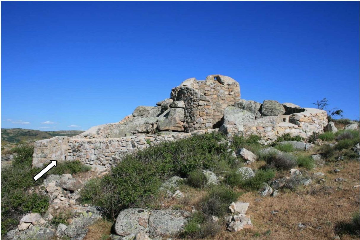
Figura 210. Accesos a posición en L. en Las Canteras (MLG-001: SMA/n), compuesto por un pasillo en ángulo recto, de mampostería con mortero de cemento.
